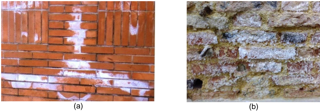
Figura 38 – (a) Eflorescência salina. (b) Eflorescência salina Arquivo Público Estadual Espírito Santo.
