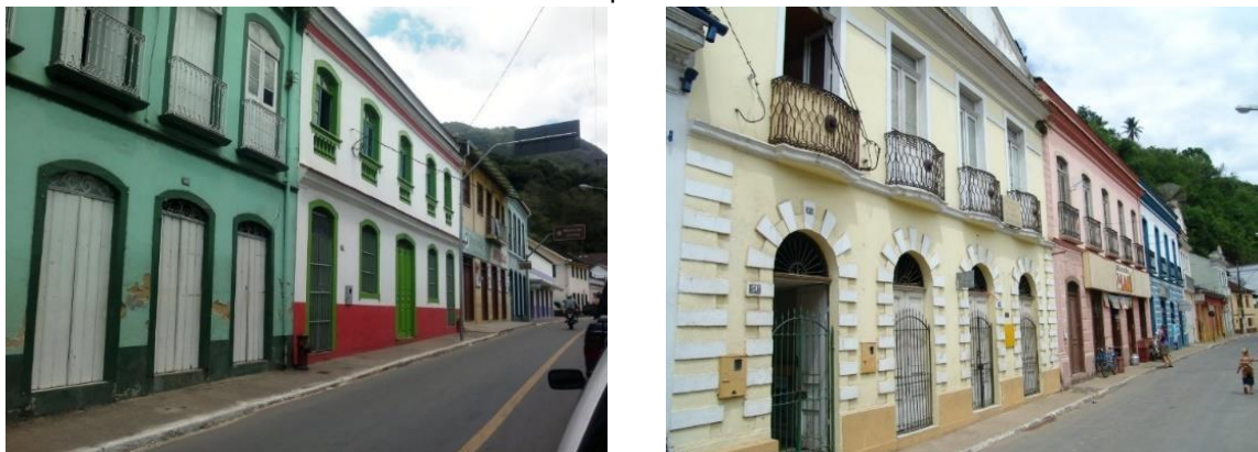
Figura 77 - Edificações remanescentes do auge econômico do núcleo urbano de Santa Leopoldina.
