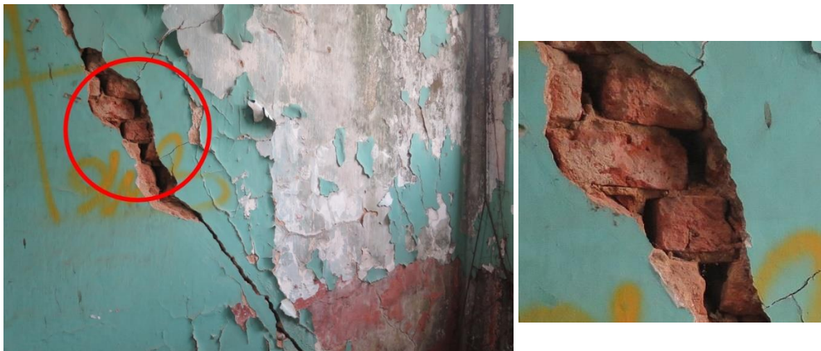
Figura 83 – Tijolos da edificação 02 apresentando descamação e fissuras, 20/11/2015.
