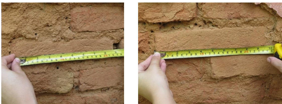
Figura 66 – Comparação entre tijolos assentados na mesma alvenaria, na fachada posterior da edificação 01
