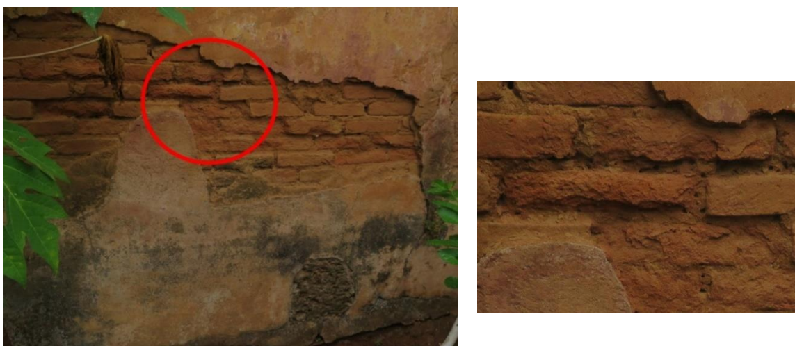
Figura 85 – Tijolos da edificação 01 apresentando descamação, 20/05/2015.
