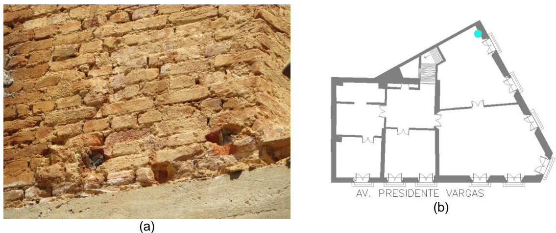
Figura 65 - (a) Alvenaria exposta edificação 02, pavimento superior. (b) localização da alvenaria na edificação 02.
