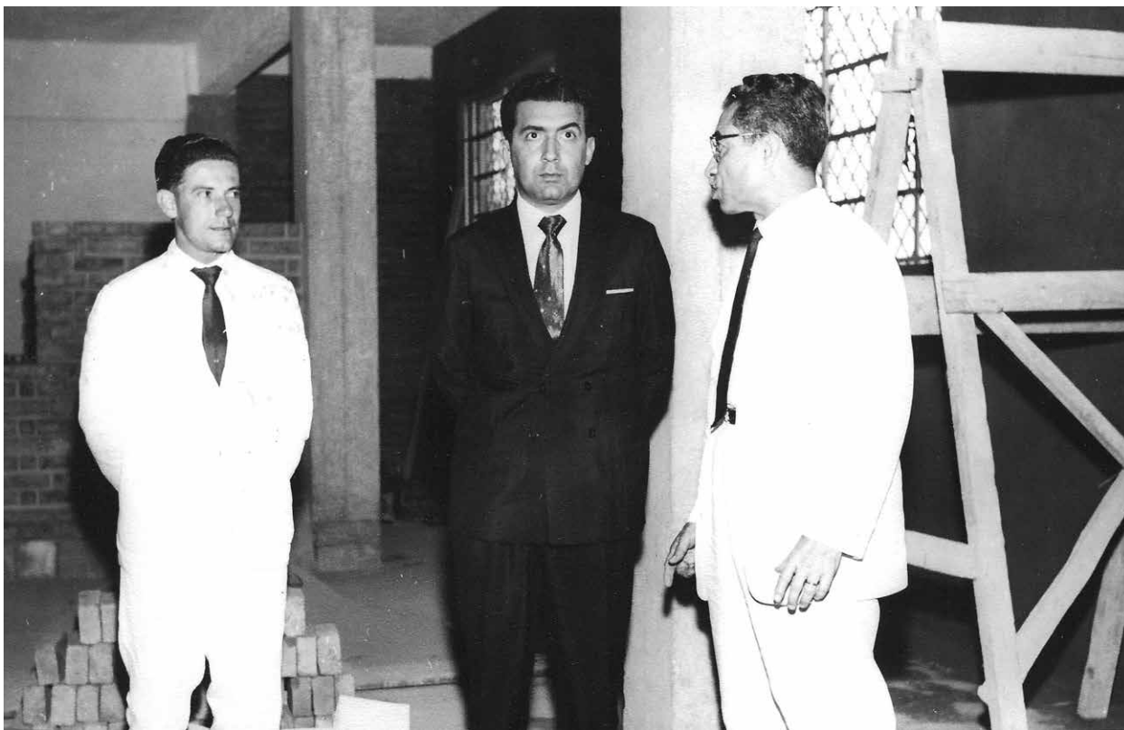
O Reitor Jair Dessaune, ao lado do secretário Alberto Monteiro e do diretor de Ensino Superior do MEC, Durmeval Trigueiro Mendes, visitando as obras da nova reitoria, no dia 17/07/1962
