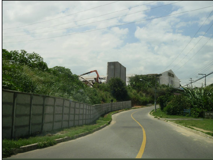
Figura 21: Entrada de Chico City e o início da demolição dos antigos galpões da Atlantic Veneer (novembro de 2010).
