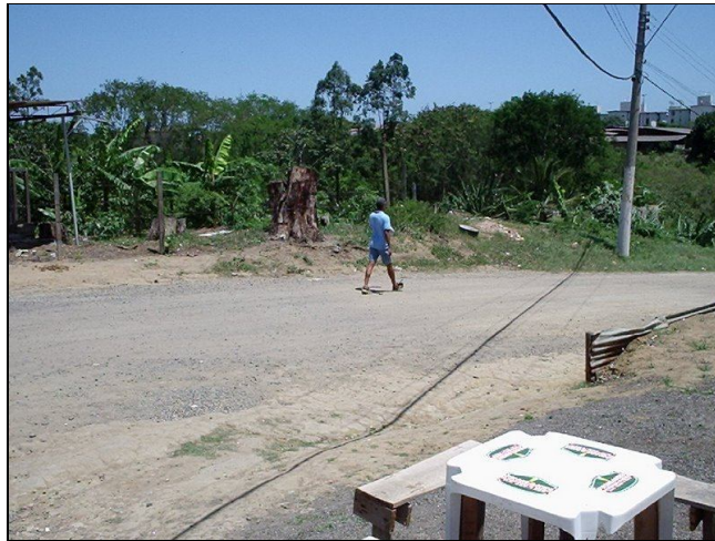
Figura 23: Entrada do bairro Chico City antes das obras de asfaltamento.
