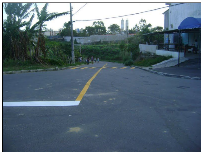
Figura 24: Entrada do bairro Chico City depois das obras de asfaltamento.
