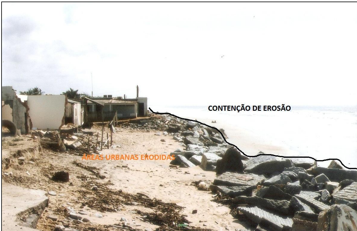
Figura 41 - Evidente processo de erosão fluvial no porto de Conceição da Barra, ES, 1998. Fonte: Acervo Cláudia Câmara do Vale.
