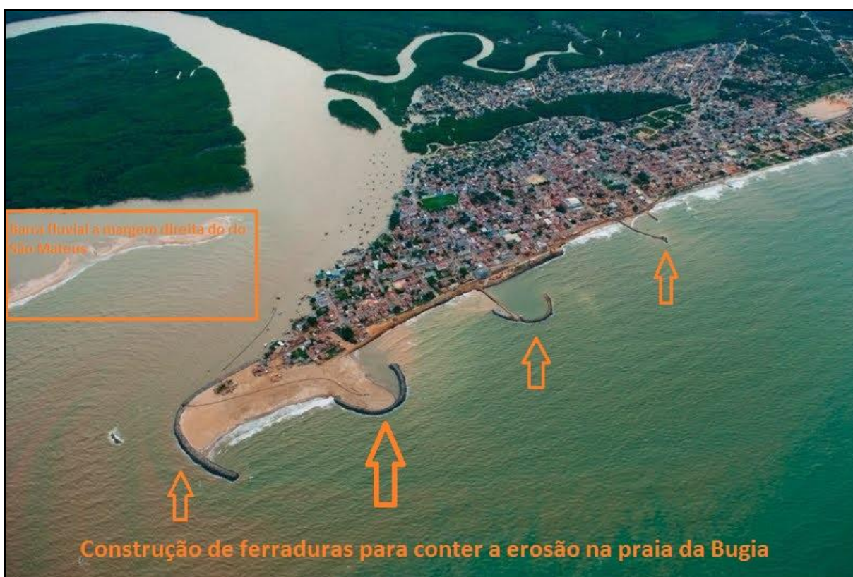
Figura 52 - Estruturas de ferraduras em construção na praia de Conceição da Barra. Fonte: http://geologiamarinha.blogspot.com.br/2010/protacao-da-linha-de-costa-no-espirito.html
