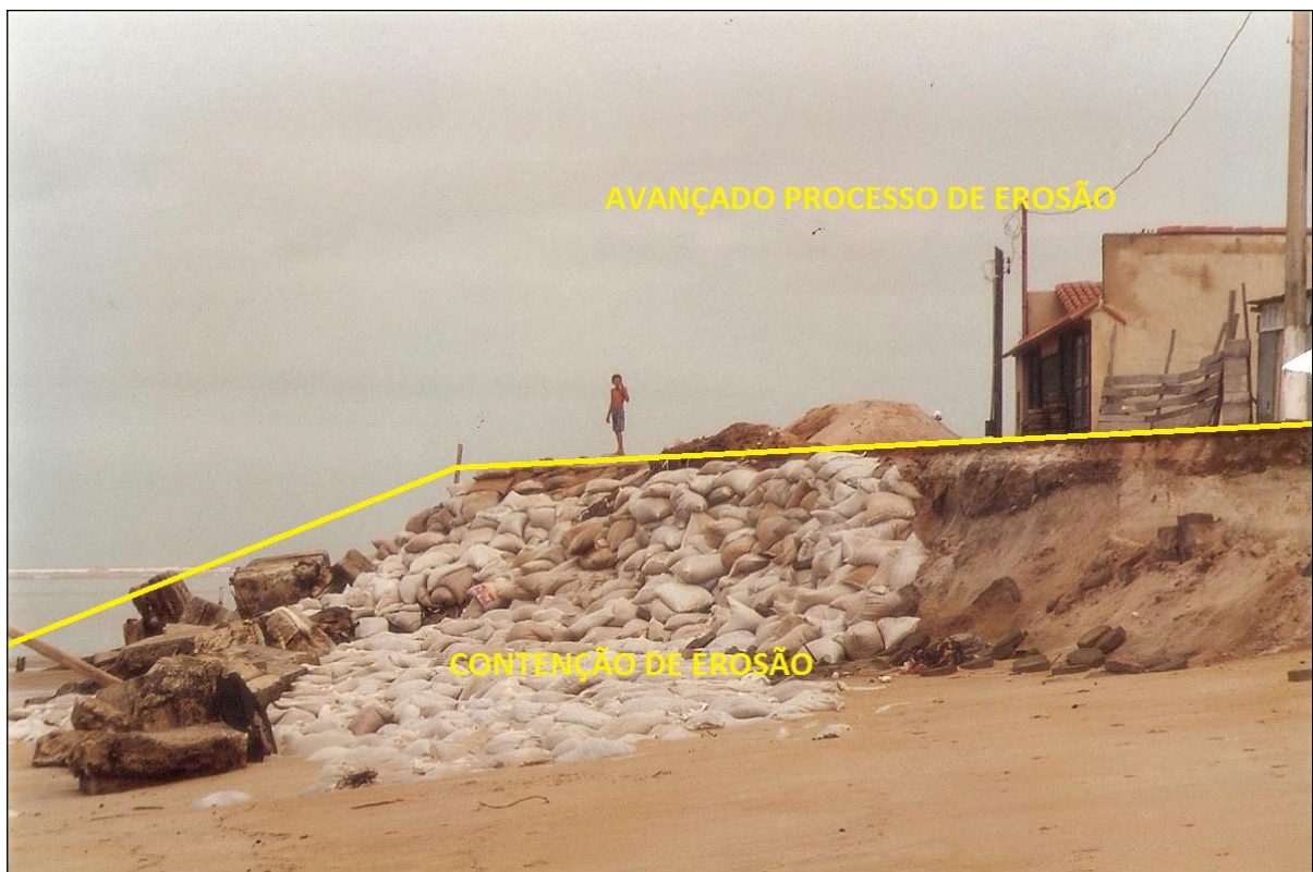
Figura 42 - Intenso processo de erosão sobre a praia da Bugia e o início da destruição deste trecho da cidade. Fonte: Acervo fotográfico de Cláudia Câmara do Vale.
