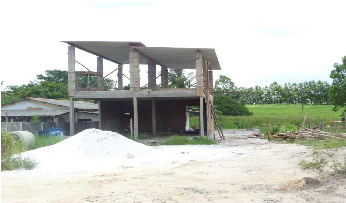
Figura 9, Casa em construção em Baixo Quartel
