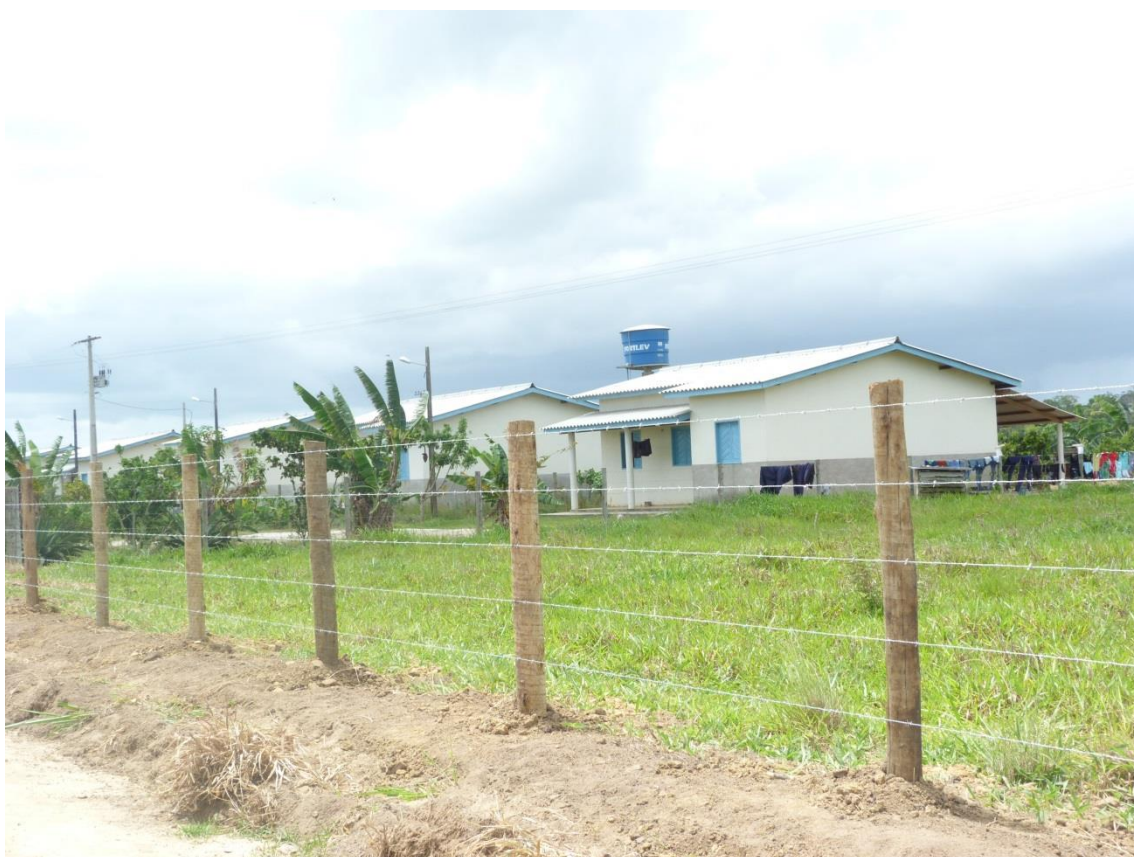
Figura 6, Casas de empregados de fazenda realocados
