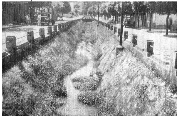
Figura 24. Foto do Córrego Jucutuquara canalizado, possivelmente na década de 1930.
