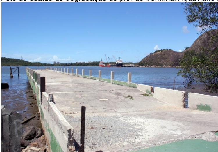
Figura 57. Foto do estado de degradação do píer do Terminal Aquaviário Dom Bosco.
