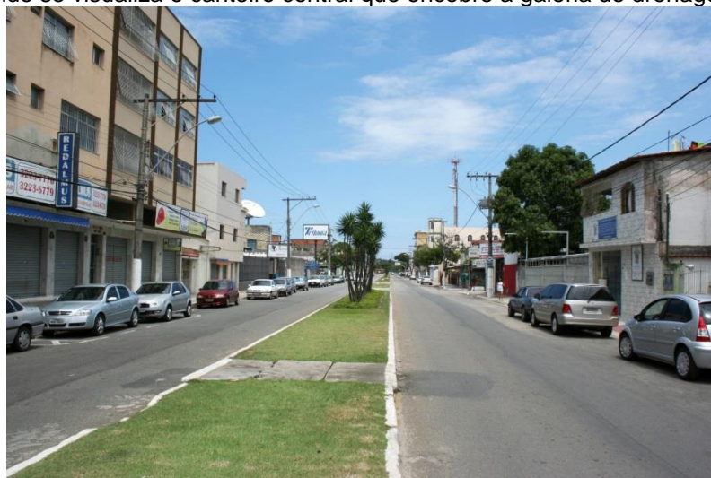
Figura 31. Avenida Paulino Muller, no bairro de Ilha de Santa Maria, onde se visualiza o canteiro central que encobre a galeria de drenagem.
