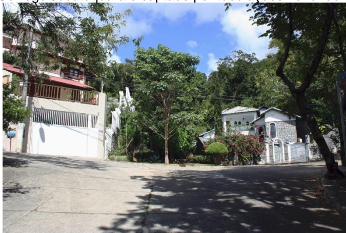
Figura 36. Cruzamento das ruas Zemínio de Oliveira e Teotônio Vilela, onde o Córrego Jucutuquara é captado por tubulações no fundo dos lotes.
