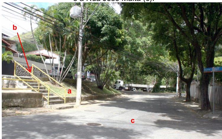
Figura 42. Desnível (a) existente entre a Rua Alexandrina Barreto Monjardim (b) e a Rua José Malta (c).
