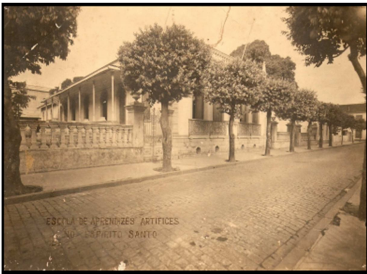
Fotografia 3 – Segundo prédio onde foi instalada a EAA-ES Fonte: Arquivo do Ifes (autoria desconhecida)
