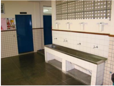
Foto 7: Hall de entrada do bloco de salas de aula
