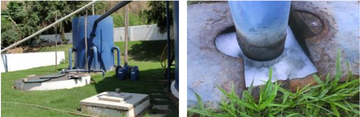
Figura 3. Ponto da coleta do efluente tratado na estação de tratamento de Jerônimo Monteiro-ES.
