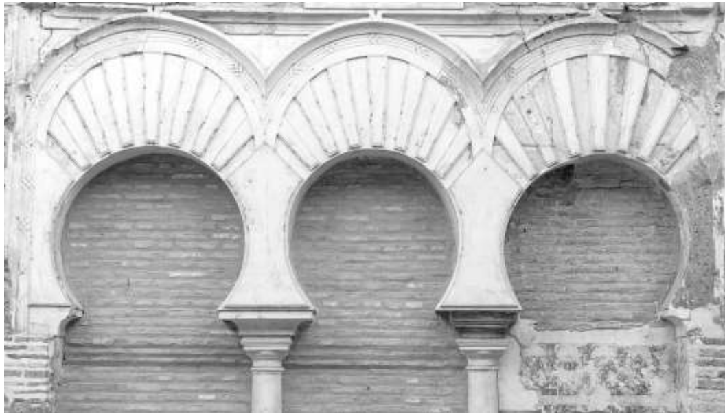
Figura 163: arcos em ferradura do Patio del Yeso do Alcázar de Sevilla – Espanha, 1364.
