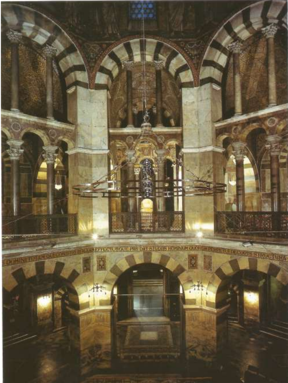
Figura 179: intradorsos bicolores dos arcos da Catedral de Aachen – Alemanha, c. 792. Fonte: TOMAN, 2000, p. 33.
