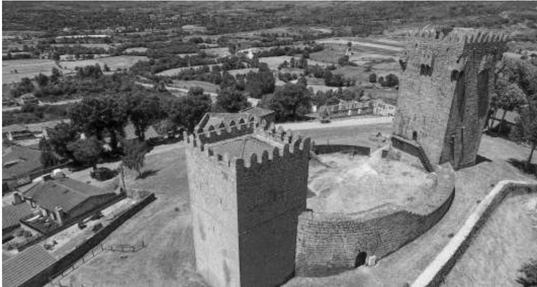
Figura 112: no alto da torre, ameias encimadas por pináculos. Castelo de Montalegre – Portugal. Séc. XIII.
