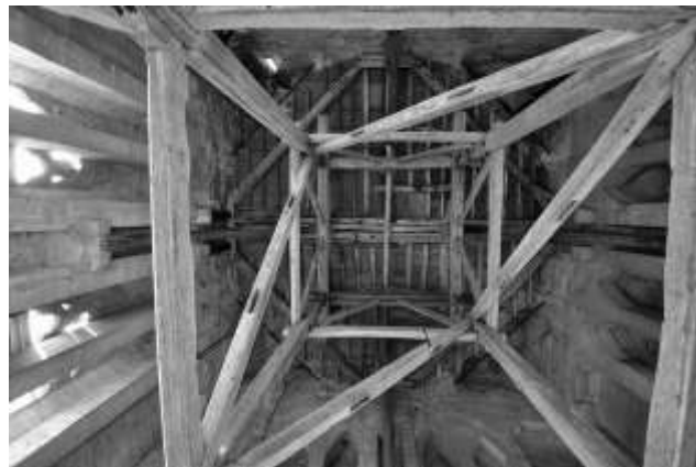
Figura 185: plataforma de madeira vista de baixo. Catedral de Salisbury – Inglaterra, 1220. Fonte: SALISBURY CATHEDRAL. Internet, http://www.salisburycathedral.org.uk/visit/tower-tours
