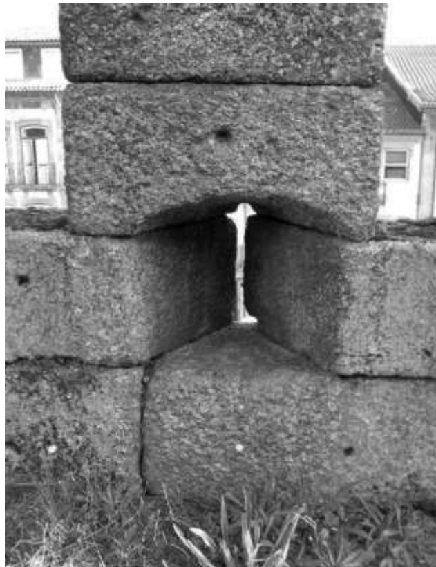
Figura 30: interior chanfrado da seteira da muralha. Guimarães – Portugal. Séc. X. Fonte: PATRIMÓNIO CULTURAL DE PORTUGAL. Internet, www.patrimoniocultural.gov.pt .
