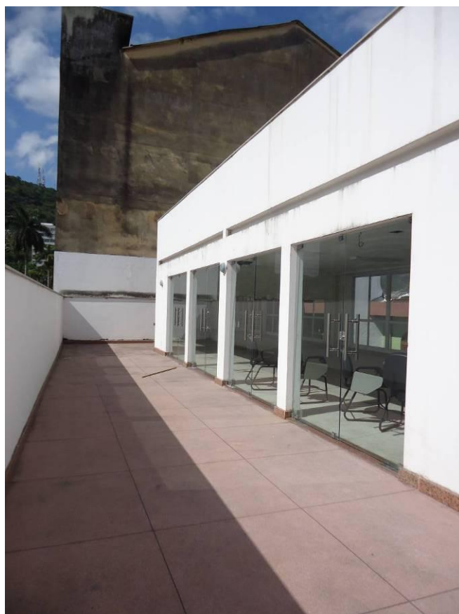
Figura 17 – Varanda. Fonte: própria
