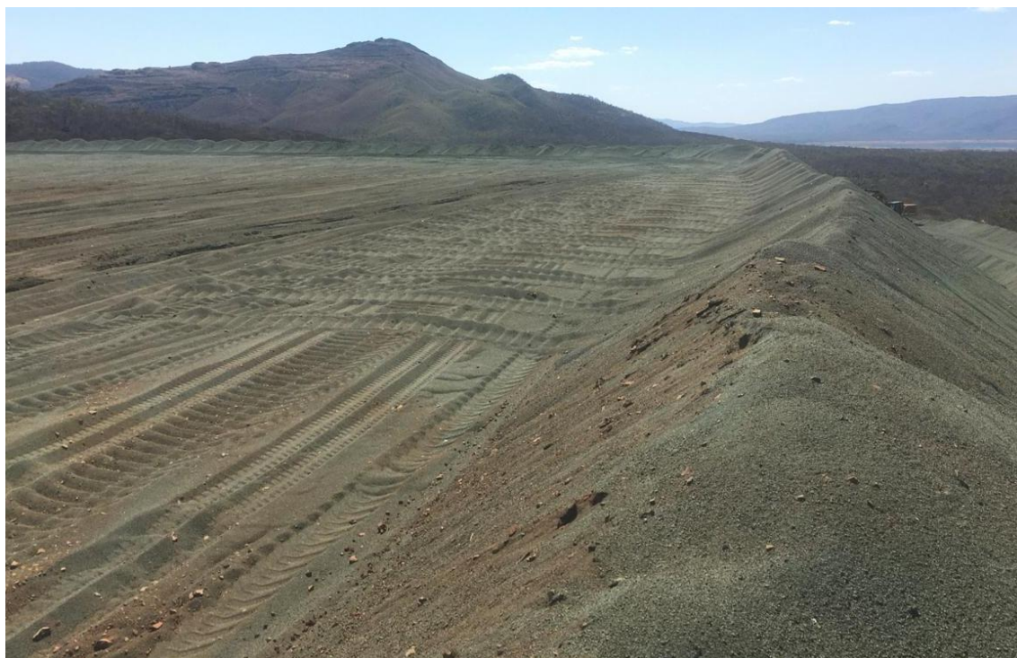
Figura 29 – Depósito de Escória de ferroníquel em Barro Alto-GO.
