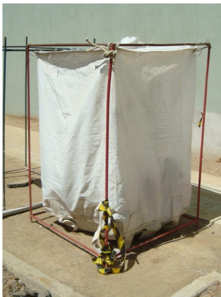
Figura 14 – Big Bag no canteiro de obra com suporte adaptado.
