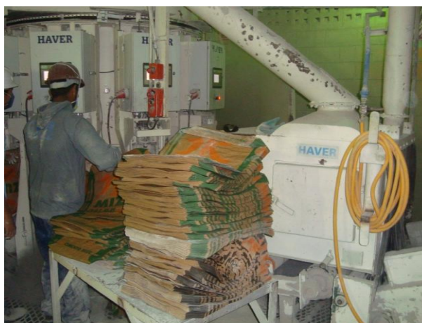
Figura 9 - Processo de ensacamento do cimento.
