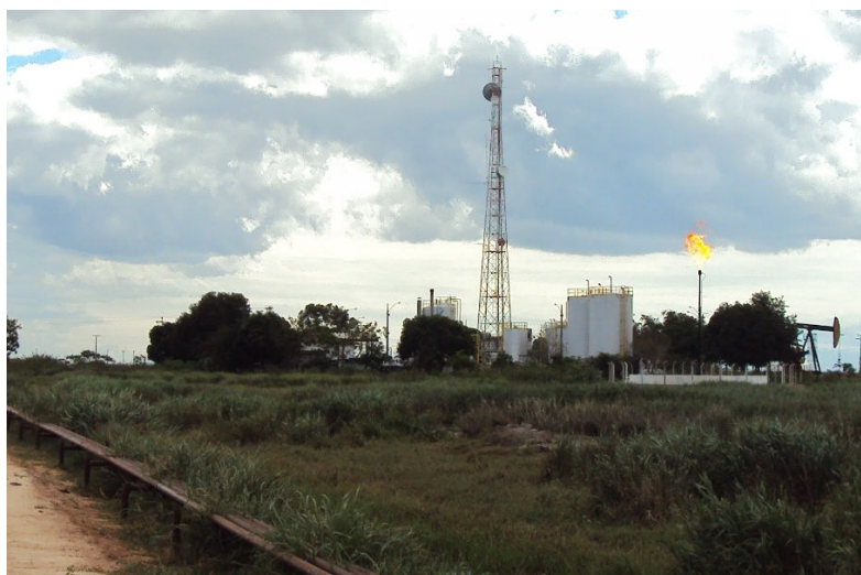
Figura 30 – Tanques de armazenamento de óleo e dispositivo de queima de gás instalados na ECT Santa Luzia, distrito de Povoação
