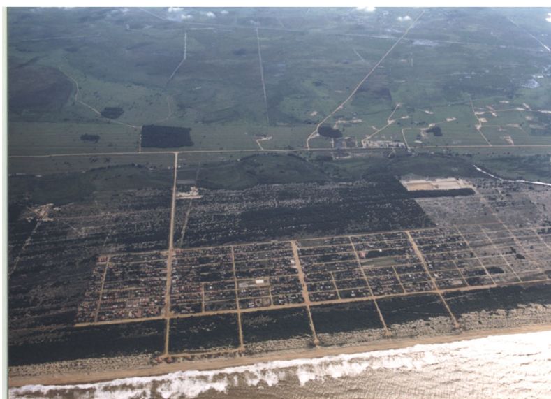
Figura 20 – Balneário de Pontal do Ipiranga, litoral norte do município: na retroterra do aglomerado urbano estão localizadas a Estação Lagoa Suruaca e as bases de poços instaladas no campo de produção de mesmo nome (Foto: IBAMA).
