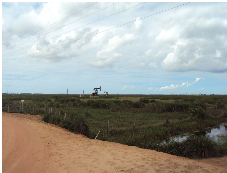
Figura 23 - Base em terreno sujeito a alagamento: gradiente de cerca de 1 a 2 m entre a cota das bases dos poços e a cota do terreno (foto do autor)
