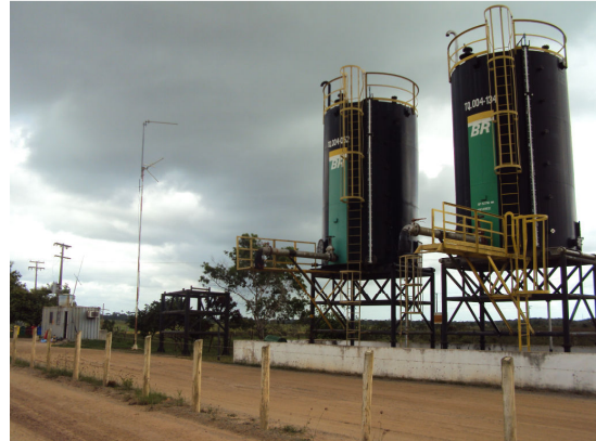
Figura 29 – Dispositivos de estocagem de óleo junto a base de poço no Campo de Produção Fazenda São Jorge (foto do autor)
