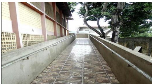
Figura 2 - Visão lateral do prédio anexo.
