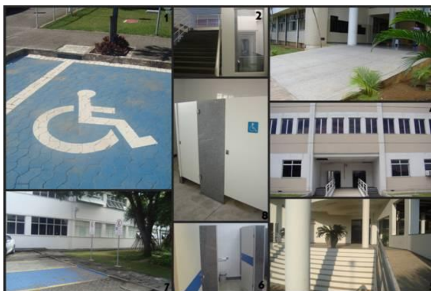
Foto 24: Imagens de medidas adequadas de acessibilidade 15 .
