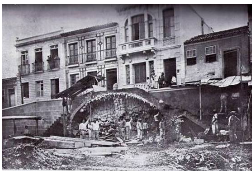
Figura 53 – Obras de reforma da Praça João Clímaco Fonte: MIRANDA, 2014
