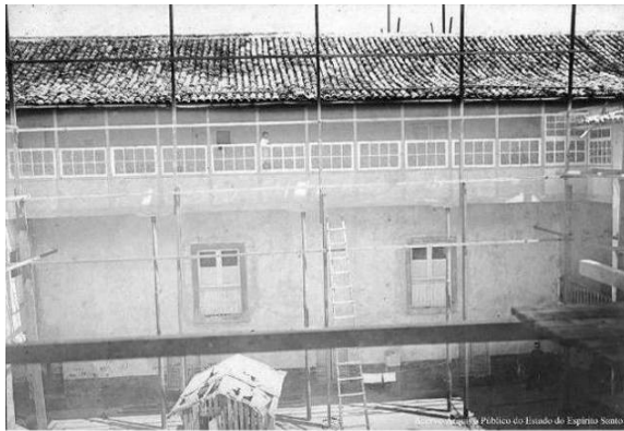
Ostra do antigo palácio, ainda em remodelação - 1910.
