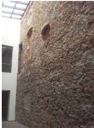
Figura 58 - Estruturas expostas da alvenaria original do período jesuítico. Parede do atual acesso às galerias de exposição, primeiro pavimento
