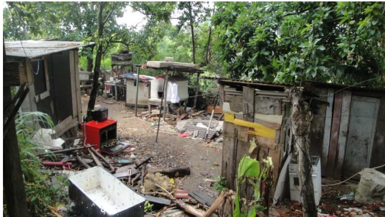
Foto 15 - Precariedade dos barracos no Forte São João (Fonte: Arquivo pesquisa).
