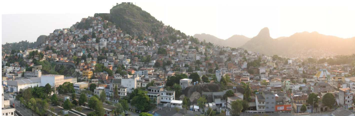
Foto 02 – Vista de um dos morros de Vitória ocupados pela população (Fonte: Acervo PMV)
