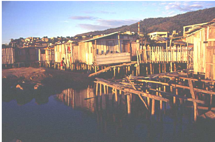
Foto 04 – Palafitas construídas sobre a maré na Região da Grande São Pedro (Fonte: Acervo PMV)
