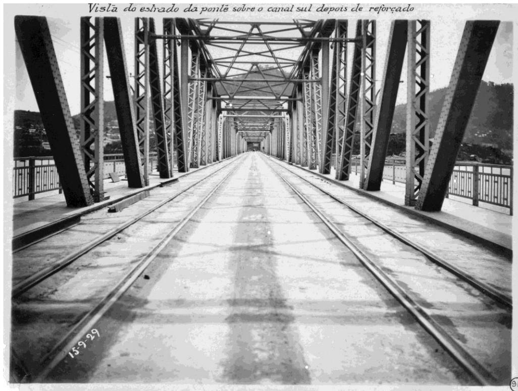
Fotografia 24 – Arquivo 000112 – Ponte Florentino Avidos (Cinco Pontes). Vista do estrado da ponte sobre o canal sul depois de reforçado. Data precisa: 15/9/1929, sem identificação de autoria. Fonte: Arquivo Geral do Município de Vitória
