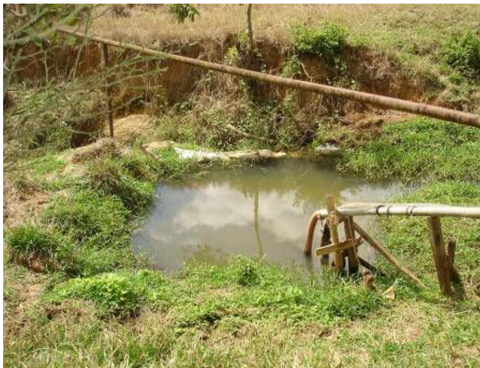
Figura 42 – Captação direta no Córrego Sossego. Detalhe para estrutura de contenção construída dentro do leito do córrego.
