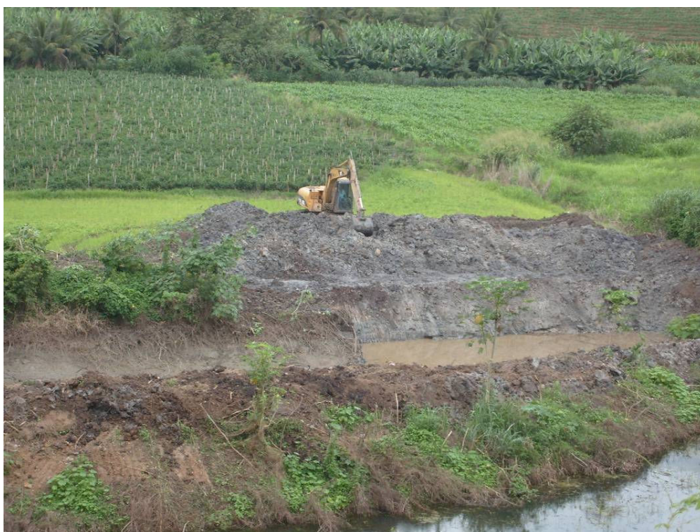
Figura 44 – Poços escavados na bacia do Sossego. Detalhe, na foto inferior, para a escavação de mais um poço no fim do ano de 2010.
