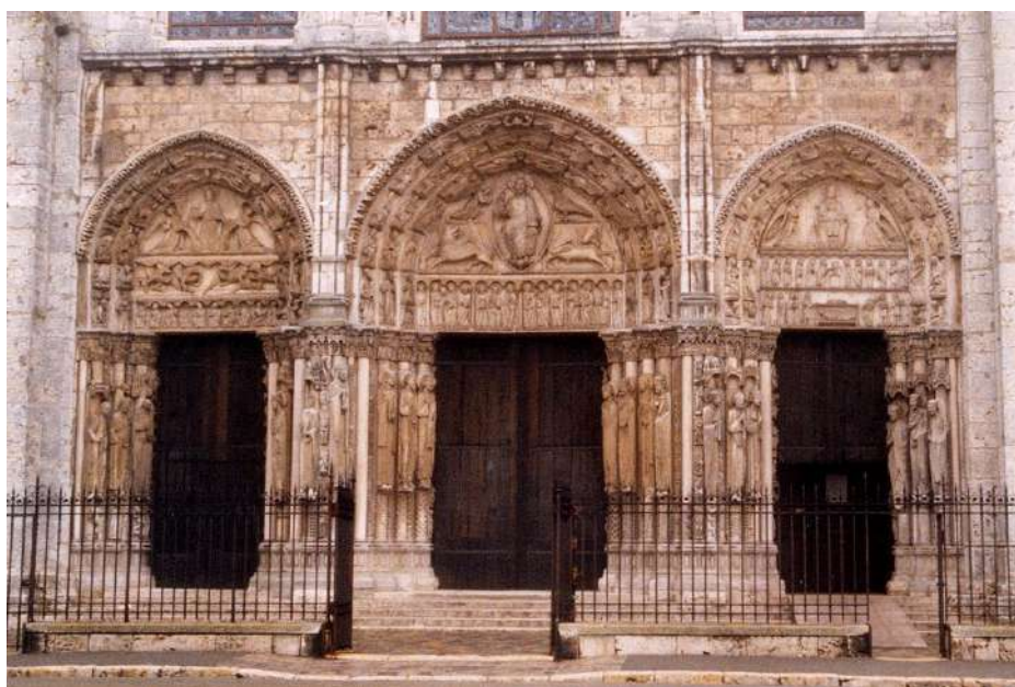
Figura 27: Portais da fachada oeste da Catedral de Chartres, c.1145-70
