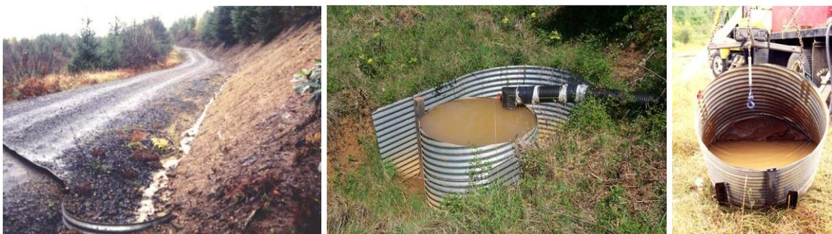
Figura 5 – Retenção de sedimentos em tanques.
