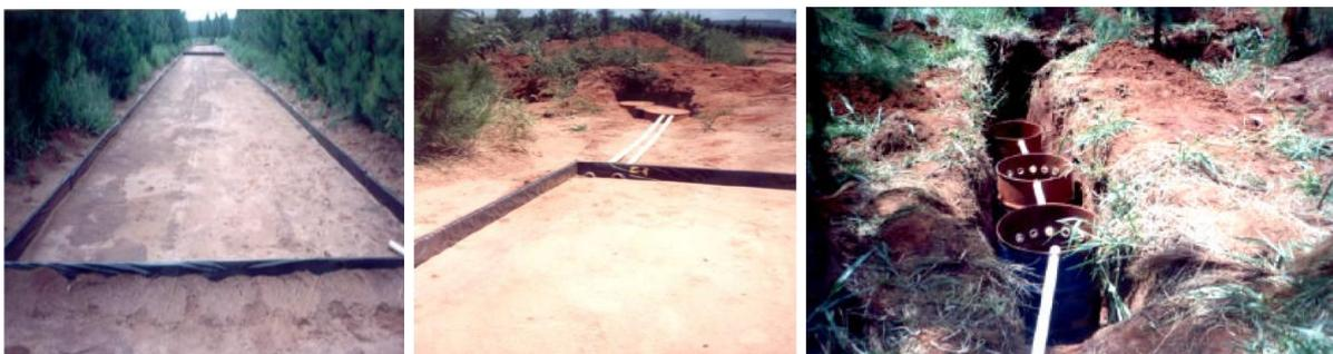
Figura 6 – Retenção de sedimentos em sequência de tanques.
