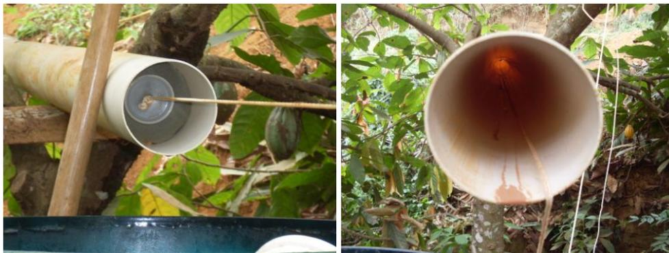
Figura 24 – Limpeza das tubulações com esponjas.
