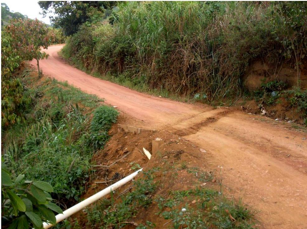
Figura 23 – Tubos de PVC para captação do escoamento no trecho de maior uso.
