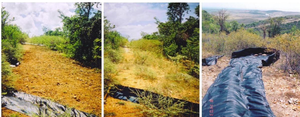
Figura 7 – Retenção de sedimentos em filtros de tecido.
