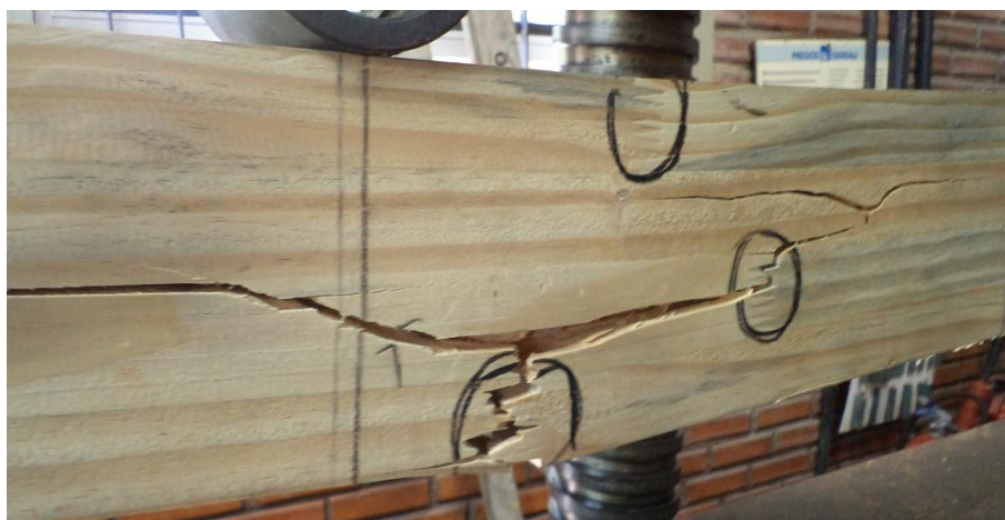
Figura B7 – Forma de ruptura da Viga 07 de Pinus
