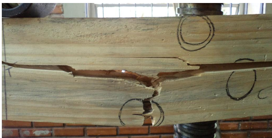
Figura B12 – Forma de ruptura da Viga 12 de Pinus
