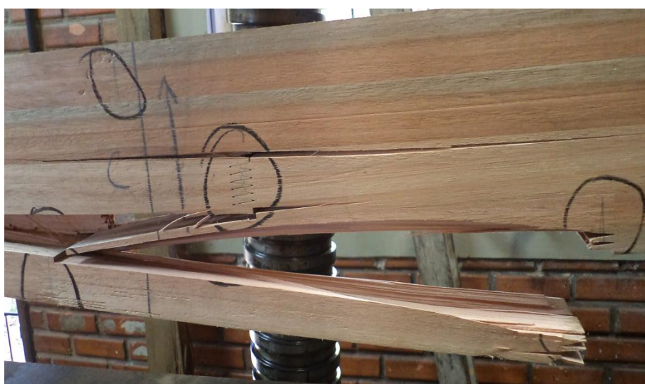
Figura A3 - Forma de ruptura da Viga 03 de Eucalipto
