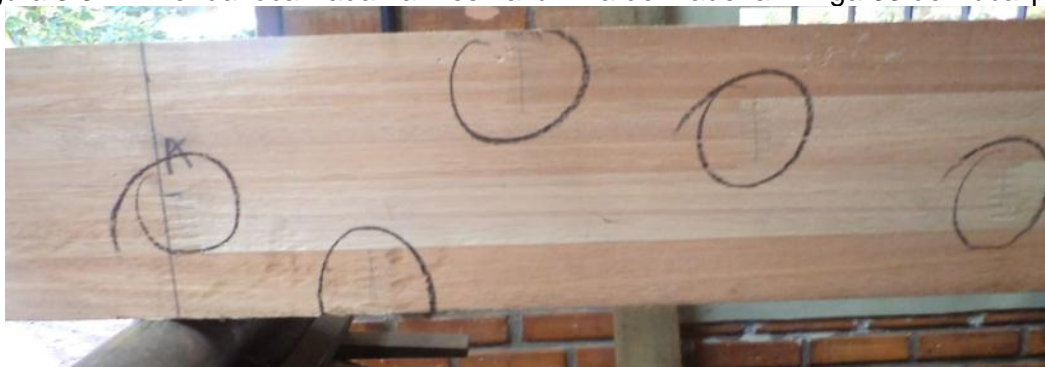
Figura 3.3 – Emenda localizada na mesma lâmina de madeira – Viga 03 de Eucalipto.
