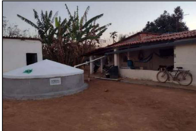
Imagem 3: Cisterna abastecida pela calha
