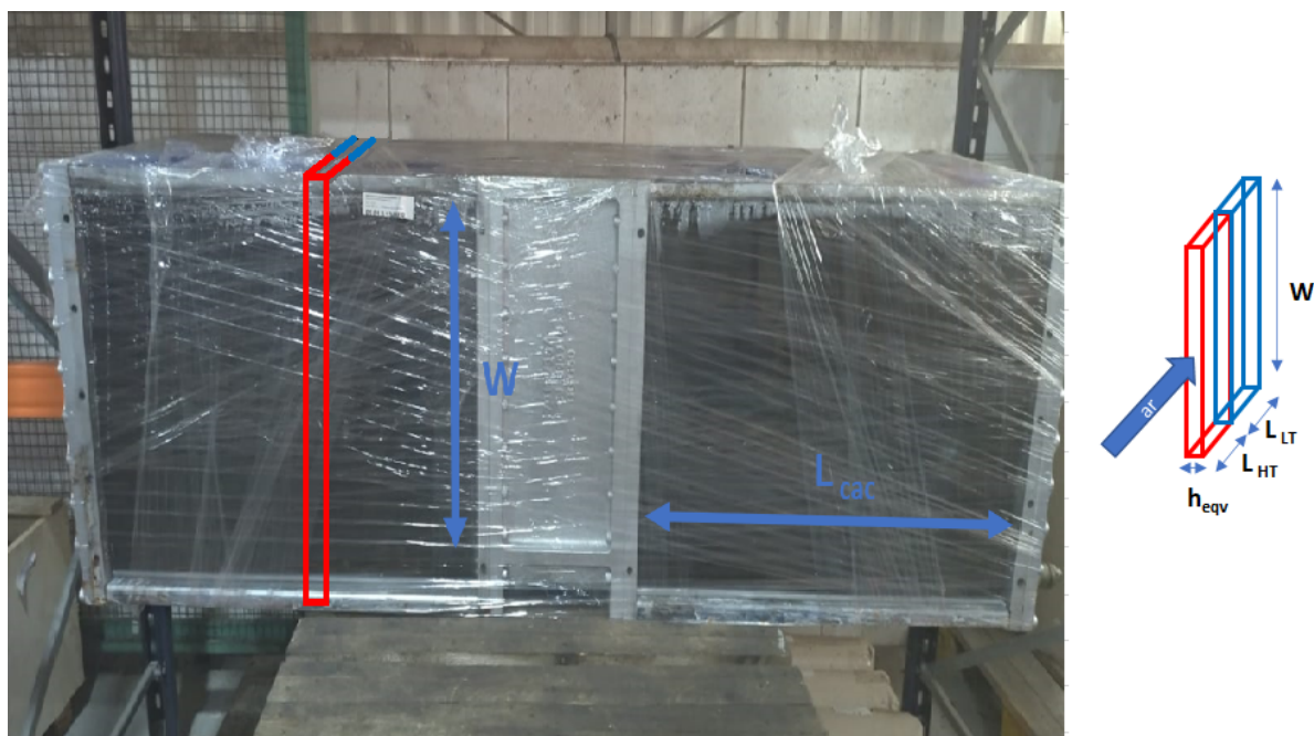
Figura 28 – Charge Air Cooler de uma unidade geradora da UTE LORM
