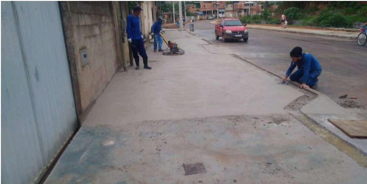
Figura 60: Obras de pavimentação e calçada na rua Santa Luzia, na Portelinha
