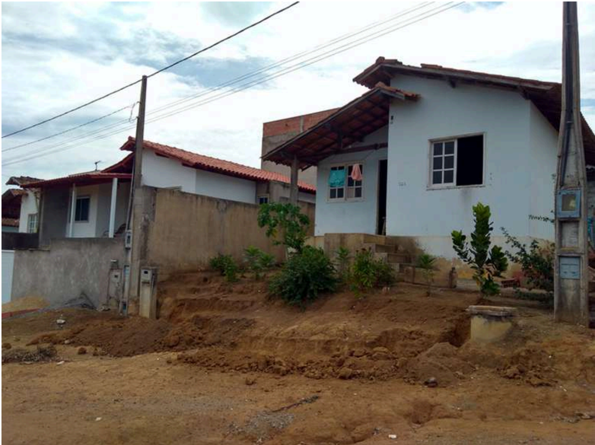
Figura 23: Padrão construtivo do Conjunto Habitacional dos Funcionários
