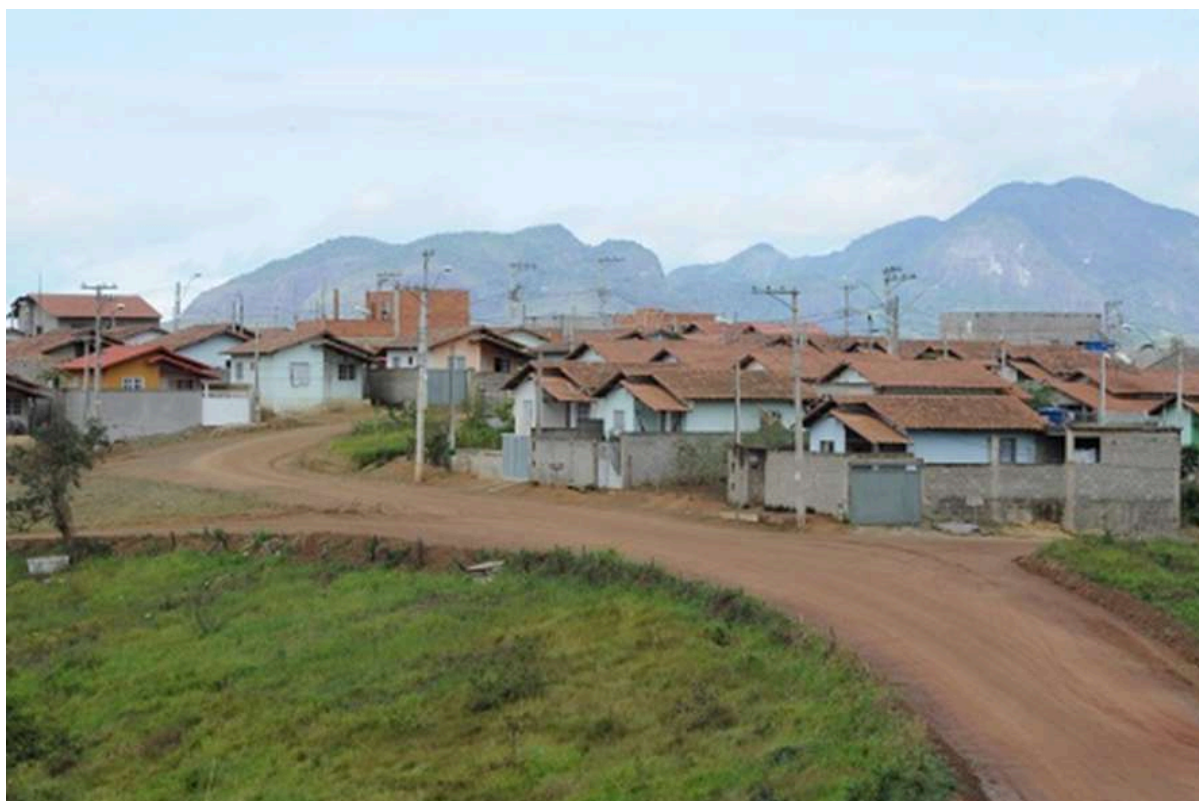
Figura 22: Infraestrutura precária no bairro Pôr-do-Sol
