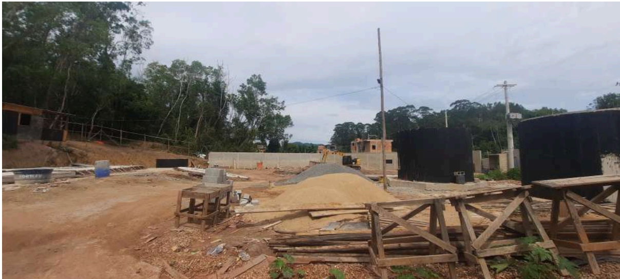
Figura 63: Construção de Estação de Tratamento de Esgoto
