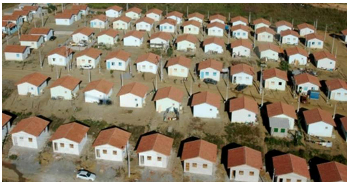
Figura 31: Tipologia construtiva das casas do bairro Nova Conquista
