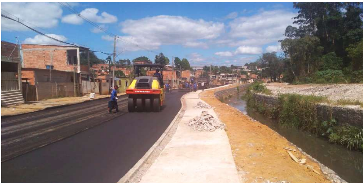
Figura 59: Obras de pavimentação na rua Santa Luzia, na Portelinha
