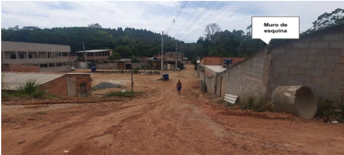
Figura 66: Rua no interior da Portelinha em 2023
