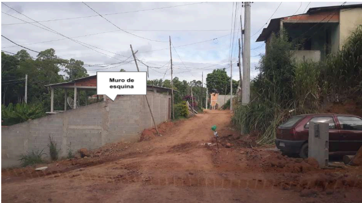
Figura 65: Rua no interior da Portelinha em 2019
