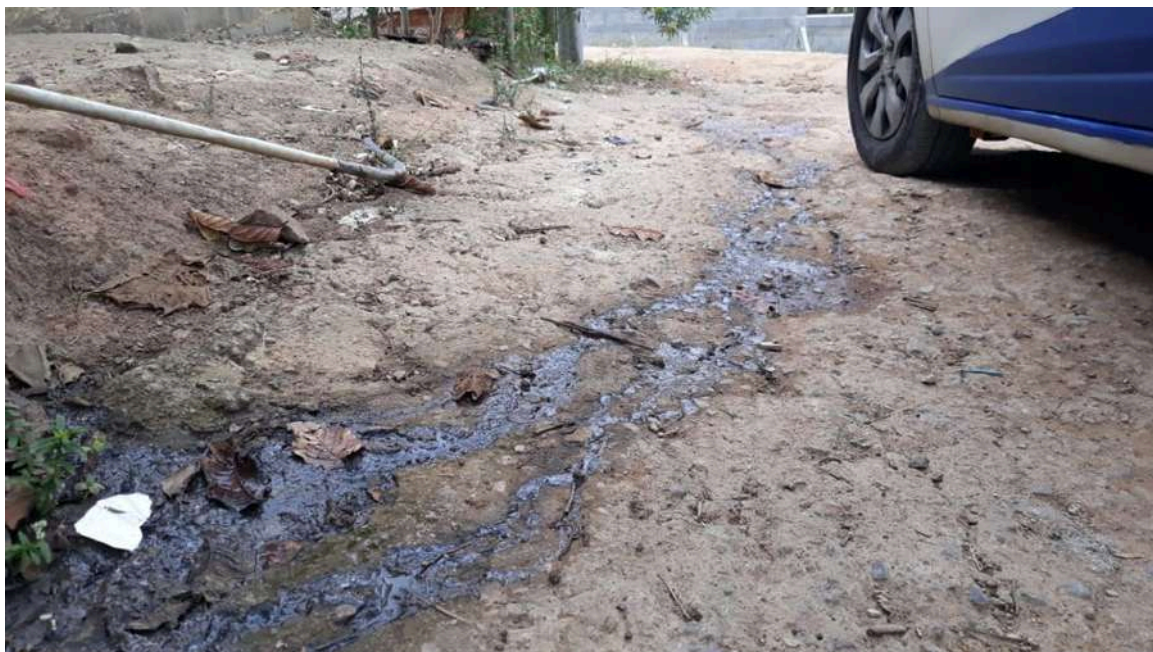
Figura 51: Esgoto a céu aberto em 2019
