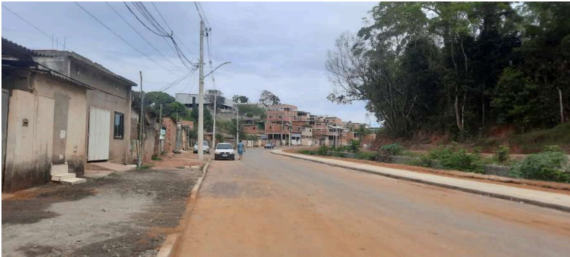
Figura 30: Obra de macrodrenagem do valão em Aracruz
