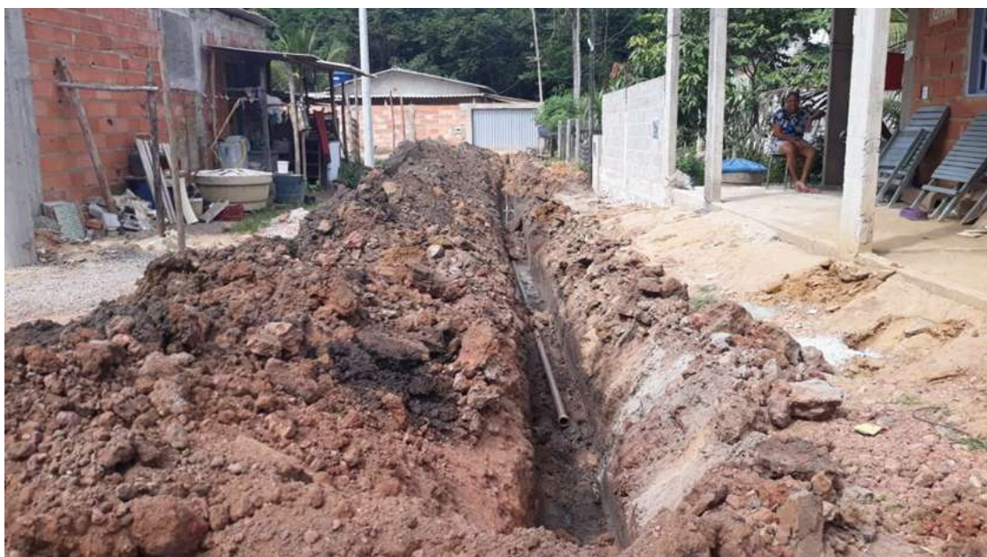
Figura 55: Instalação de rede distribuição de água em 2019
