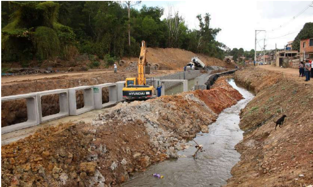
Figura 28: Obra de macrodrenagem do valão em Aracruz
