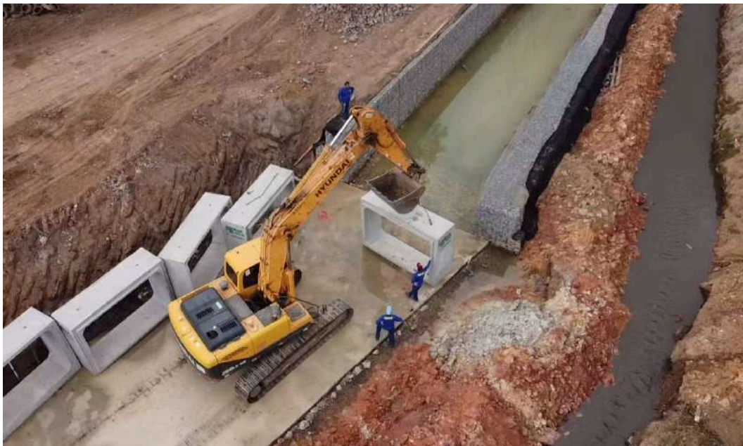
Figura 29: Obra de macrodrenagem do valão em Aracruz
