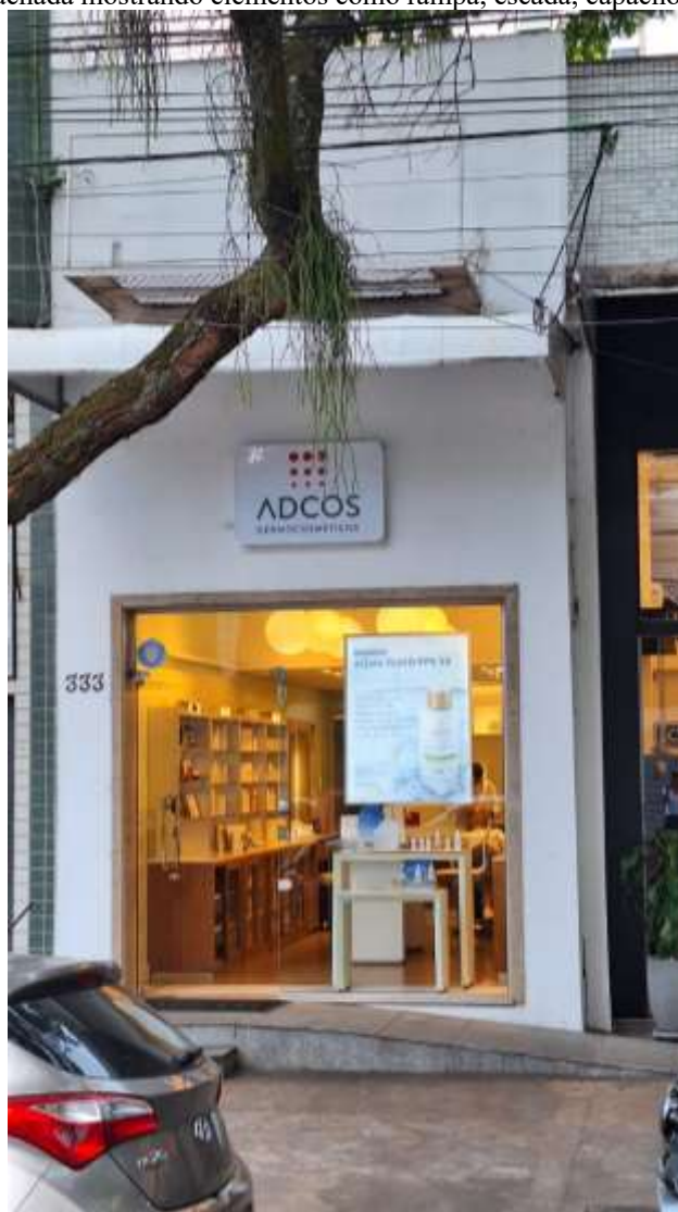
Figura 20 - Fachada mostrando elementos como rampa, escada, capacho e porta aberta
