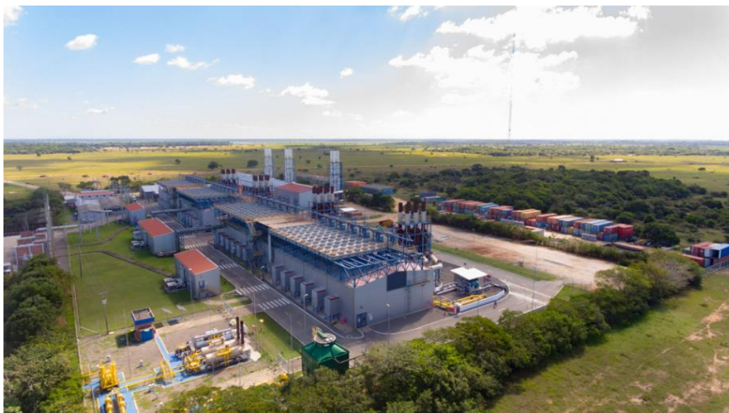
Figura 3.1 – Imagem aérea da Usina Termelétrica Luiz Oscar Rodrigues de Melo
