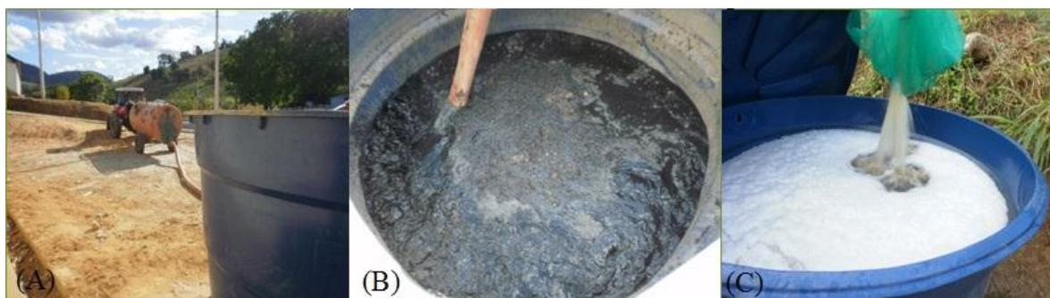
**Figura 2** - Abastecimento dos reservatórios com esgoto doméstico bruto (1A e 1B) e filtragem do esgoto doméstico bruto (1C)
