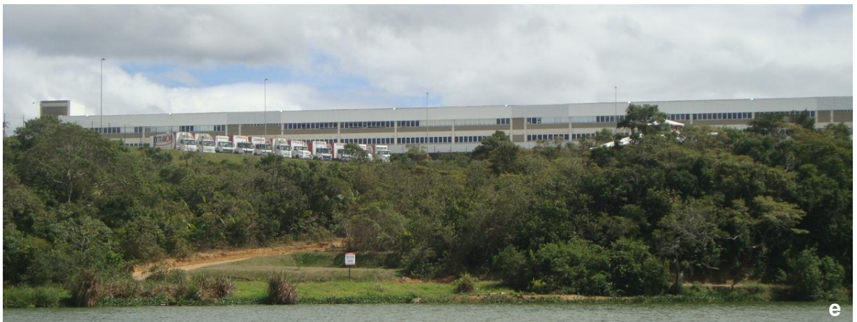
Figura 3: Fotos da lagoa Jacuném a) coloração esverdeada da água, b) margem com mata ciliar, c) Macrófitas aquáticas nas margens, d) construção do prédio da APA e e) estabelecimento comercial nas margens da lagoa (Fotos: Lorena Baptista Almeida).
