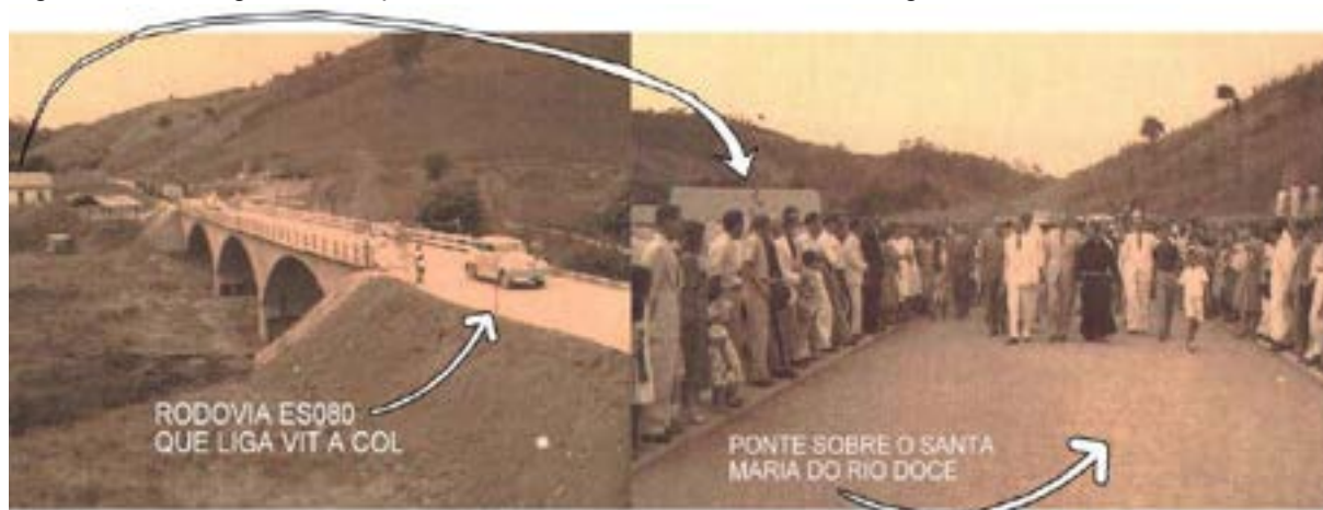
Figura 70 – O surgimento da ponte sobre o Santa Maria do Rio Doce ligando Vitória a Colatina.
