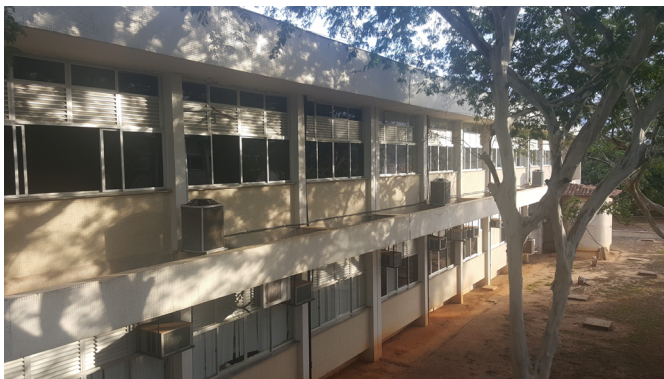
Figura 1 – Elementos existentes na fachada da edificação
