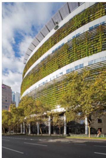
Figura 6 – Sistema de fachada verde – Edifício Seguro Nacional, Santiago, Chile
