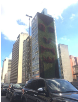
Figura 8 – Sistema de paredes vivas – Edifício no Minhocão, em São Paulo
