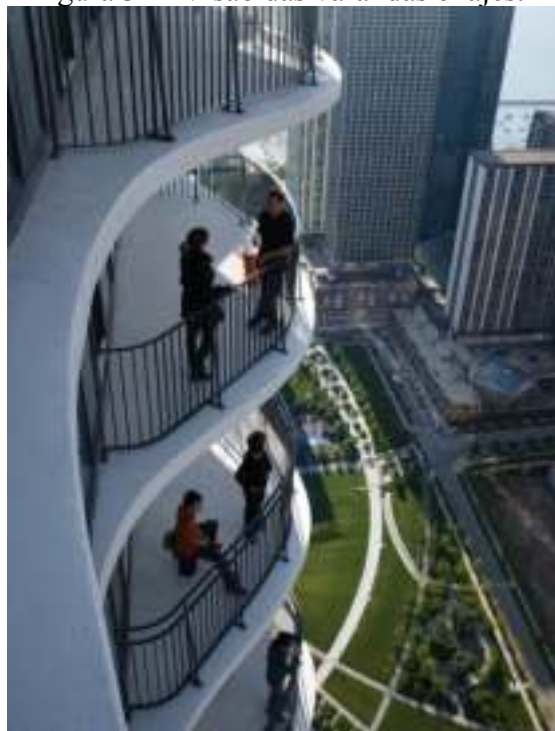
Figura 34 - Visão das varandas e lajes.
