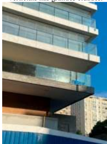
Figura 18 - Fechamento de varanda usualmente encontrado em edificações verticais nas grandes cidades.
