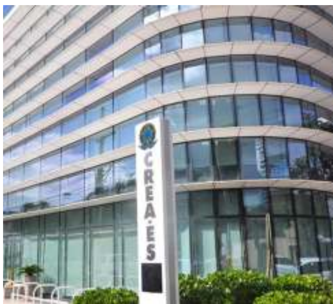
Figura 38 - Edifício do CREA-ES.
