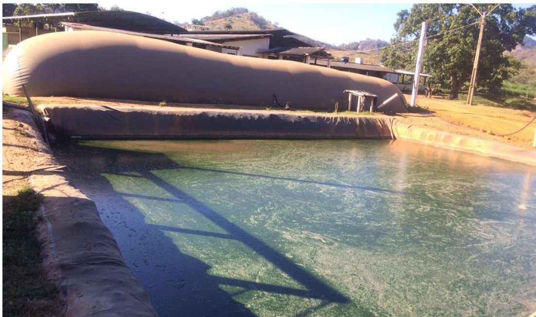
Figura 2 - Biodigestor anaeróbio e tanque impermeabilizado localizados próximos ao local de condução do experimento.
