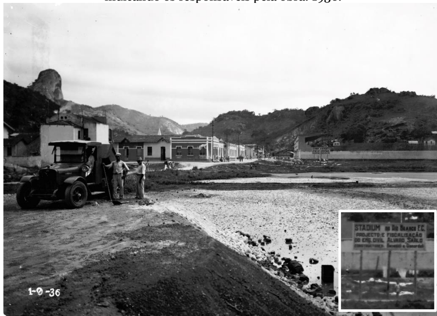
Figura 3. Vista de Jucutuquara, com destaque para as Casas dos Funcionários e, à direita, o estádio Governador Bley em construção, com uma placa indicando os responsáveis pela obra. 1936.
