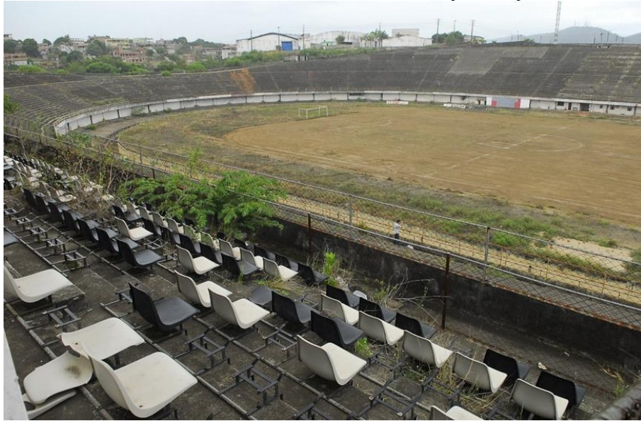
Figura 15. Estádio Kleber Andrade em processo de arruinamento após três anos de abandono até o início das obras do novo complexo esportivo. 2010.
