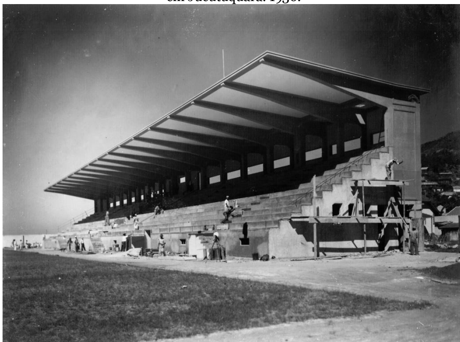
Figura 4. Operários trabalhando na construção do estádio Governador Bley, em Jucutuquara. 1936.
