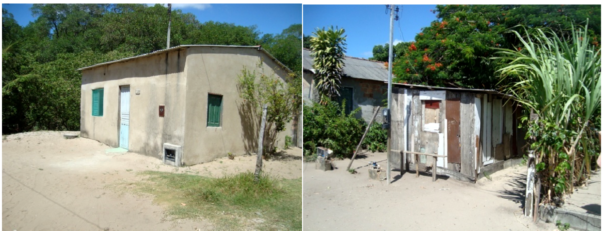
Figura 7: Condições de moradia: (A) Casa de alvenaria; (B) Casa de madeira.
