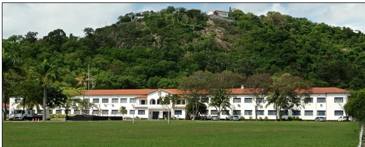
Figura 15 – Foto da fachada principal do edifício da Escola de Aprendizes-Marinheiros do Espírito Santo. Foto: a autora.
