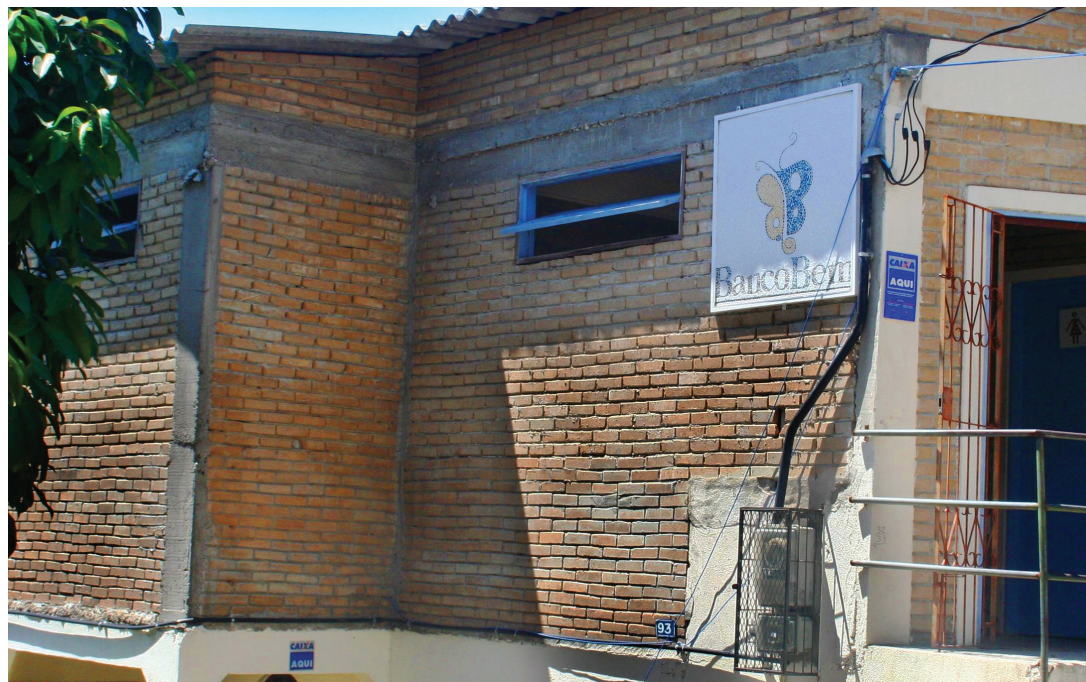
FIGURA 1.2: Sede do Banco Bem no Morro São Benedito em Vitória, ES, em setembro de 2011.
