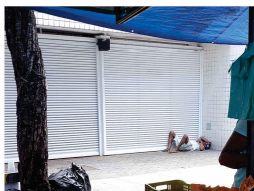
Edificação com marquise
