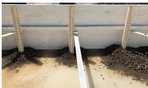
Figura 3.49: Instalação dos pontos de coleta no FRE. Fonte: Autoria própria.
