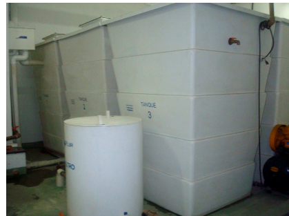
Figura 2: ETAC em escala real instalada na edificação
