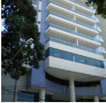
Figura 1A: Edificação dotada de reúso
