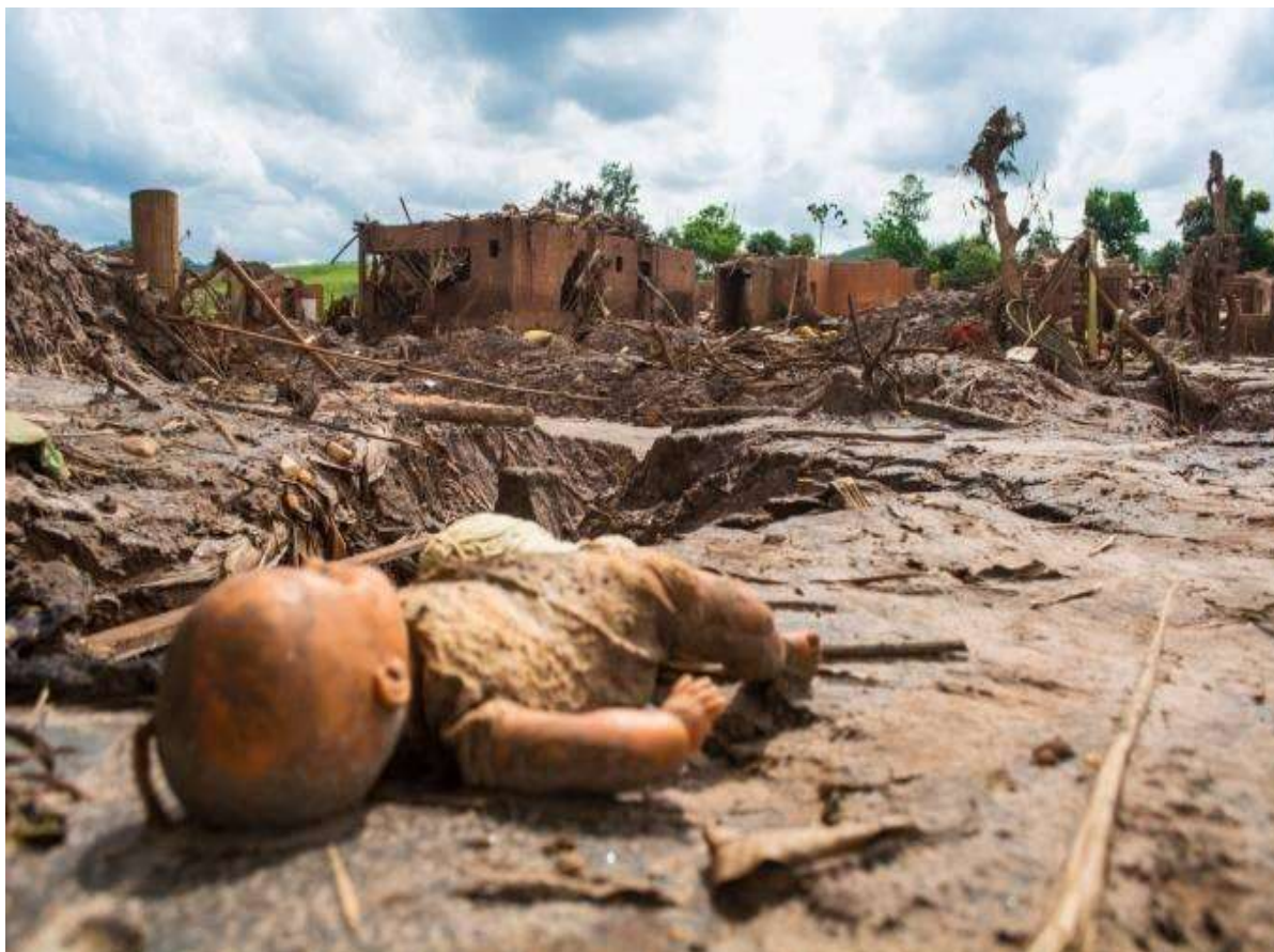
Figura 24 – Sub-distrito de Santa Rita Durão, Bento Rodrigues após a queda da barragem de Fundão.
