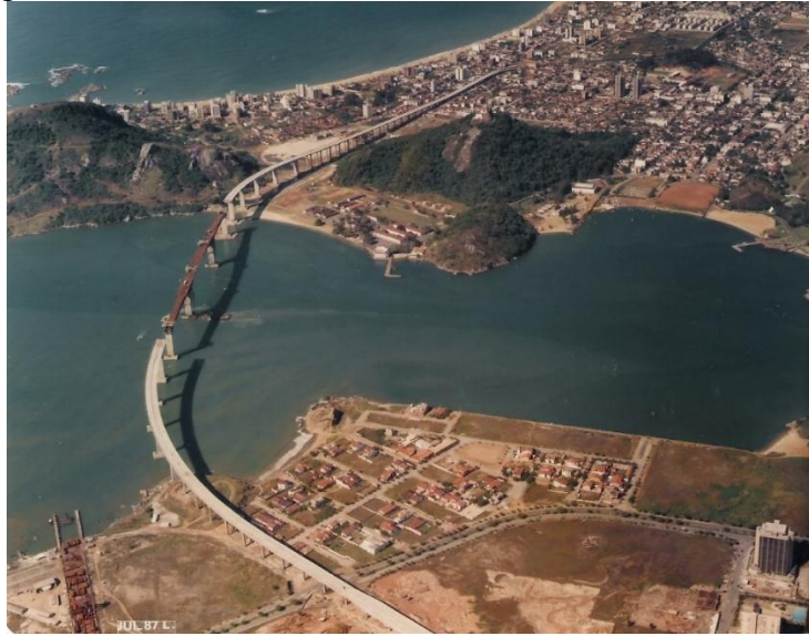
Figura 10 - Vista aérea da Enseada do Suá e da Praia da Costa
