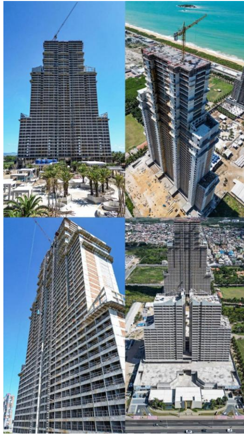
Figura 4 - Andamento da construção do Taj Home Resort em setembro de 2024
