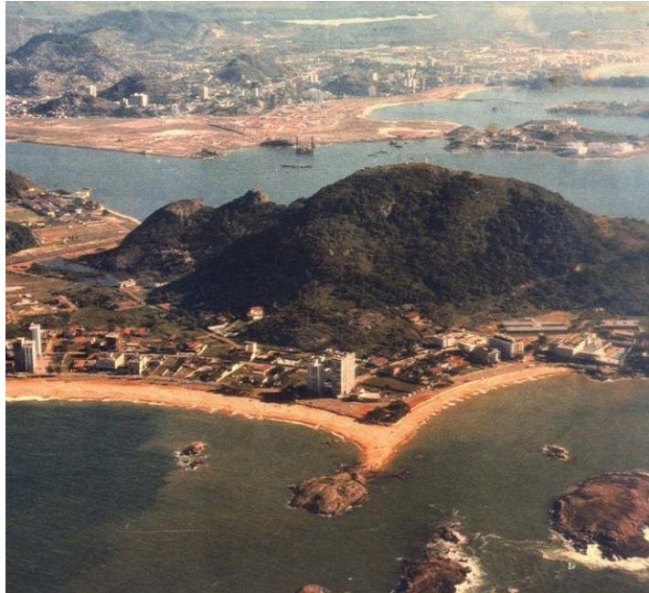
Figura 9 - Praia da Costa no início da construção da Terceira Ponte
