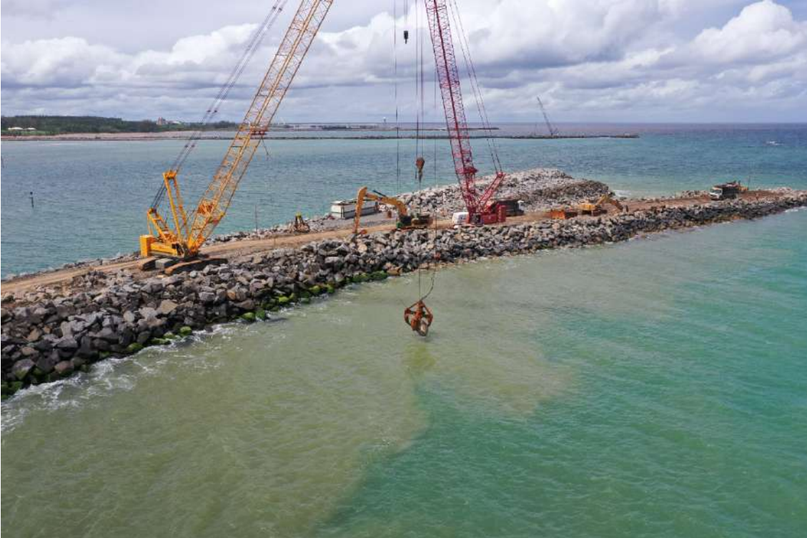
Figura 18 - Construção do quebra-mar leste que terá 2,3 quilômetros de extensão e para sua construção será utilizado um volume de 2,9 milhões de metros cúbicos de pedra
