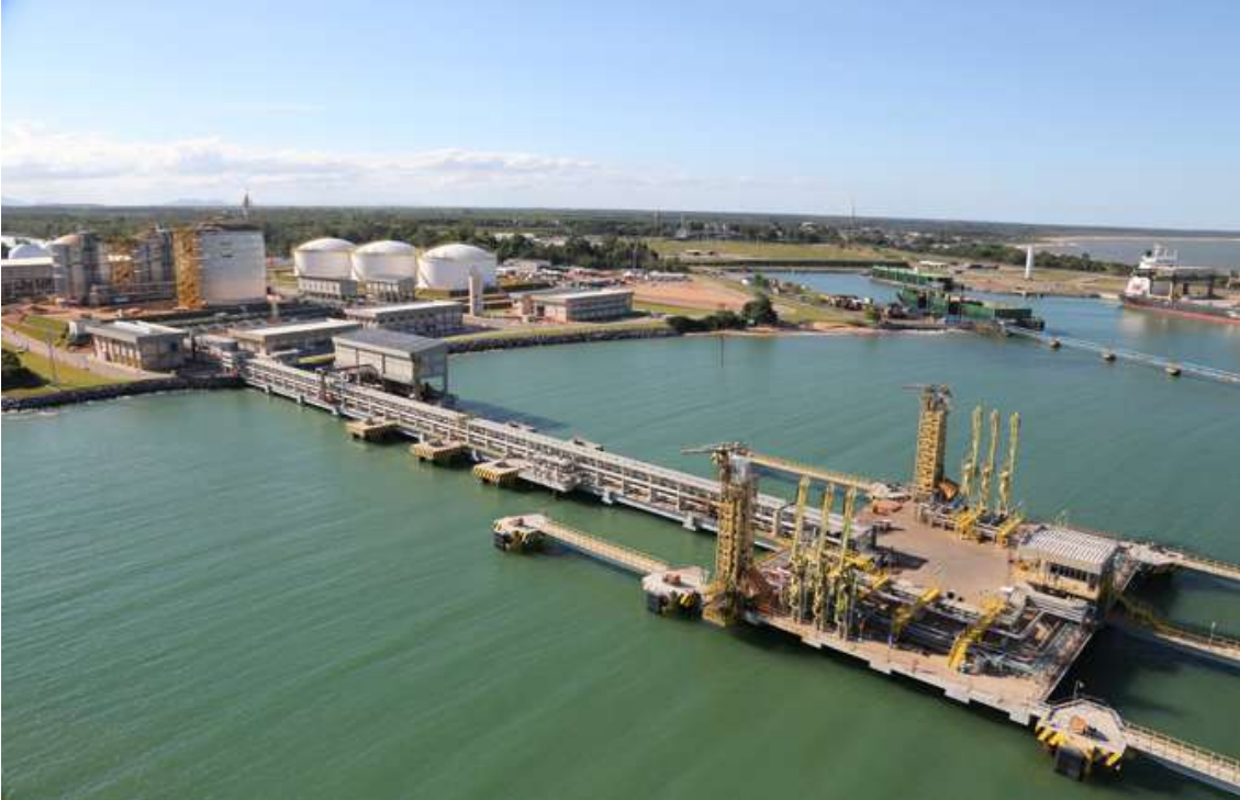
Figura 16 - Terminal Aquaviário de Barra do Riacho (TABR)
