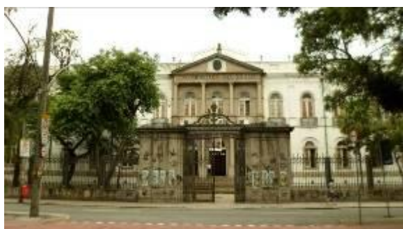
Figura 83 – Gradil com muitas pichações e sujidades. Fotografia: Flávia Monteiro (2013) Fonte: Acervo Fotográfico Pessoal.
