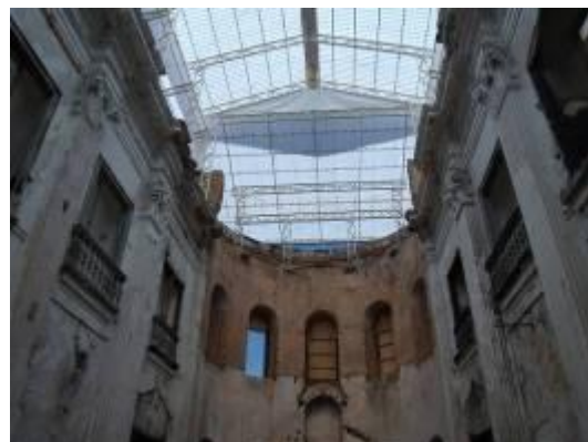
Figura 114 – Vista do telhado provisório. Fotografia: Isabele Rangel (2013). Fonte: Notícias R7.
