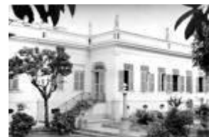
Asilo São Cornélio Rio de Janeiro – RJ Data de Construção: Século XVIII; Arquiteto: Desconhecido Data de Tombamento: 15/07/1938 Conservação: Regular
