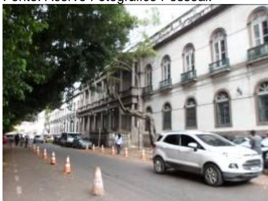
Figura 45 – Os danos na platibanda da edificação causados pela umidade do telhado apresentam-se em toda a sua extensão. Fotografia: Flávia Monteiro (2013) Fonte: Acervo Fotográfico Pessoal.
