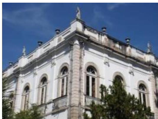
Figura 70 – Estátuas e Grandes Vasos Ornamentais que ornam a platibanda. Fotografia: Flávia Monteiro (2013) Fonte: Acervo Fotográfico Pessoal.
