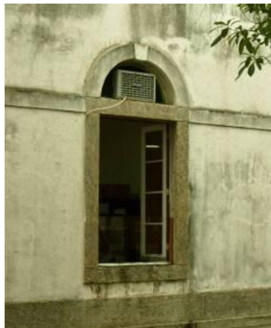
Figura 108 – Instalação de aparelho de ar condicionado na bandeira da janela. Fotografia: Flávia Monteiro (2013) Fonte: Acervo Fotográfico Pessoal.
