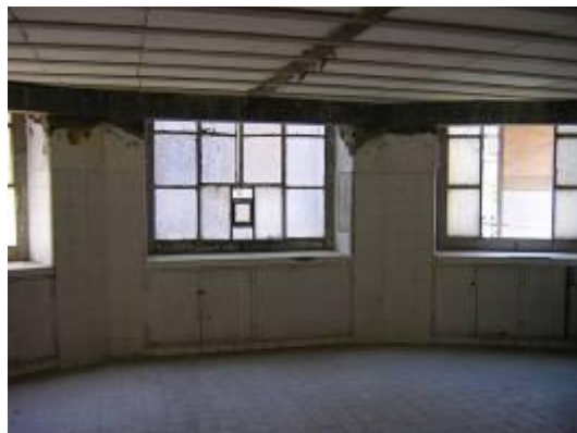
Figura 142 – Laje pré-moldada que estrutura o Mezanino do Primeiro Pavimento. Fotografia: Desconhecido. Fonte: Plano Diretor, 2004.
