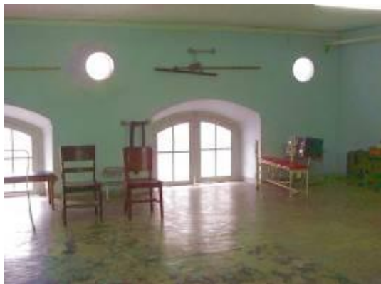
Figura 141 – Vista Interna do Mezanino interferindo na esquadria da edificação. Fotografia: Desconhecido. Fonte: Plano Diretor, 2004.
