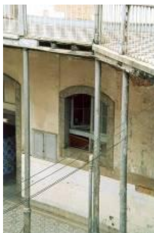
Figura 160 – Detalhe da Circulação Externa onde é possível encontrar vestígio da Passarela que ligava os raios à Torre do Panóptico. Fonte: Plano Diretor, 2004.
