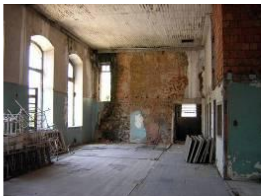
Figura 151 – Vista Interna do Primeiro Pavimento do Prédio 3, onde é possível observar o estado das paredes, do forro e do piso em madeira. Fotografia: Desconhecido. Fonte: Plano Diretor, 2004.
