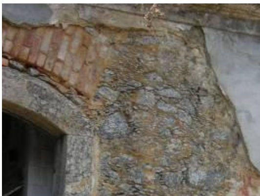
Figura 152 – Detalhe da Alvenaria Mista que estruturaram os prédios originais. Fotografia: Desconhecido. Fonte: Plano Diretor, 2004.
