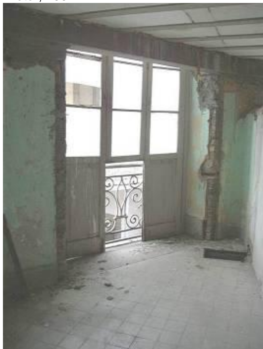
Figura 143 – Vista interna do vão correspondente à Torre de Observação que ligava à passarela. Fotografia: Desconhecido. Fonte: Plano Diretor, 2004.
