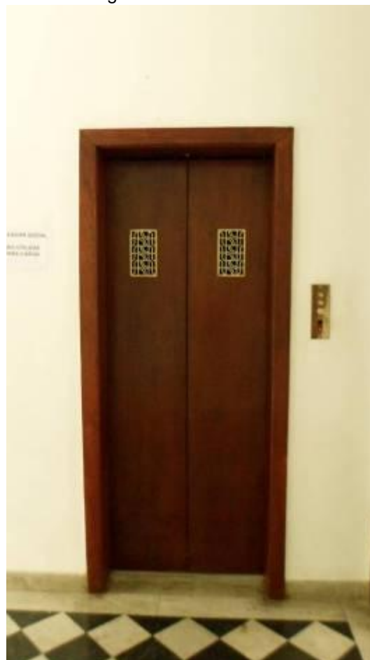
Figura 110 – Elevador próximo ao Gabinete de Coordenação do Fórum de Ciência e Cultura. Fotografia: Flávia Monteiro (2013) Fonte: Acervo Fotográfico Pessoal.
