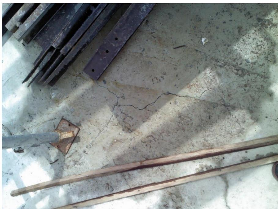
Já a reação química do hidróxido de cálcio no concreto pode afetar a proteção das armaduras passivas e comprometer sua aderência, uma vez que a carbonatação do concreto muda o pH, logo esse deixa de ser um ambiente básico e passa a ser um ambiente ácido.
