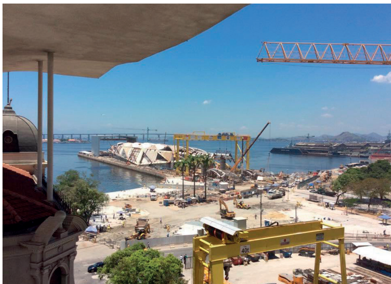
Vista das obras na região portuária do Rio de Janeiro. Fotografia própria.
