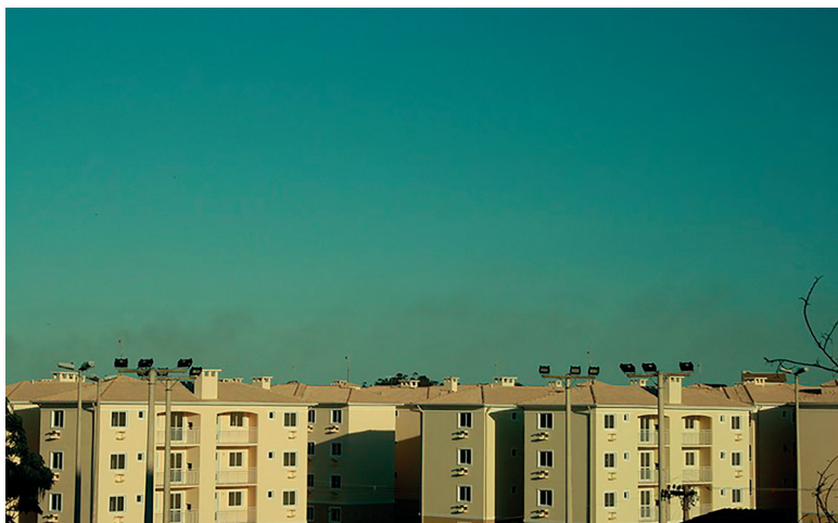
Condomínio tipo vila italiana (Brasil). Fotografia própria.
