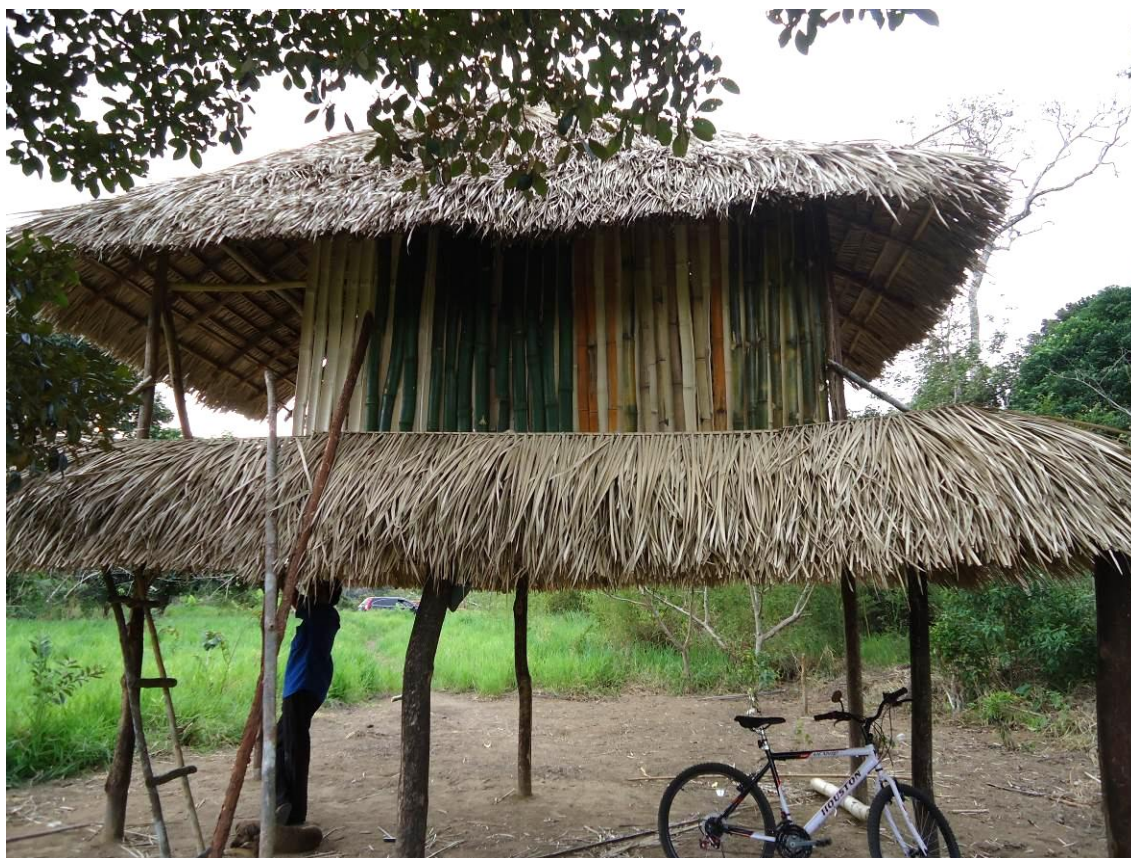
Figura 11: Índio guarani construindo sua casa.
