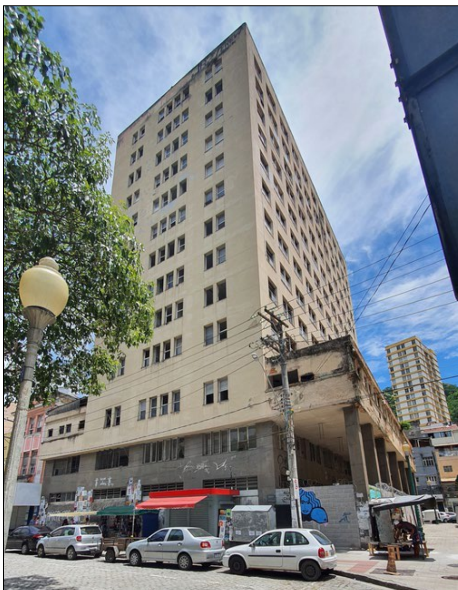
Figura 13 – Edifício Getúlio Vargas (IAPÍ) ainda abandonado
