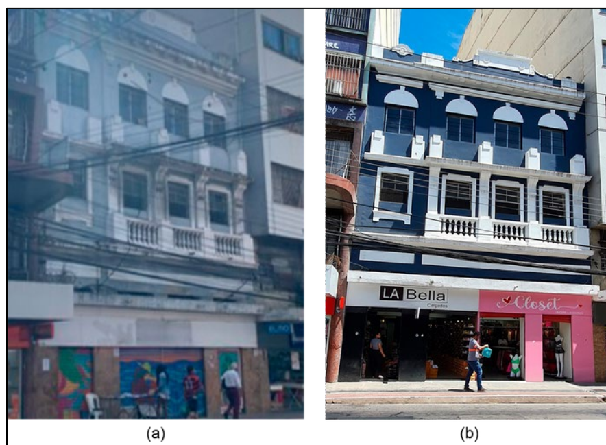
Figura 23 – Imóvel B49 teve conversão de uso de não utilizado para subutilizado : (a) fotografia registrada em 2021 e (b) fotografia registrada em 2024
