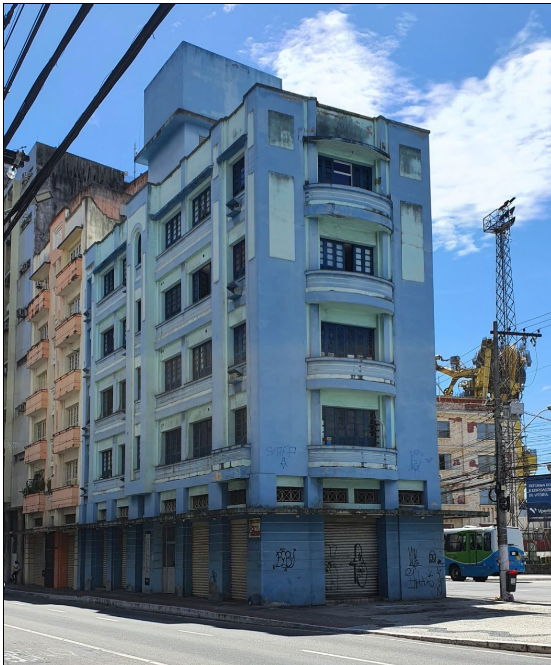
Figura 9 – Edifício Pouso Real após reabilitação
