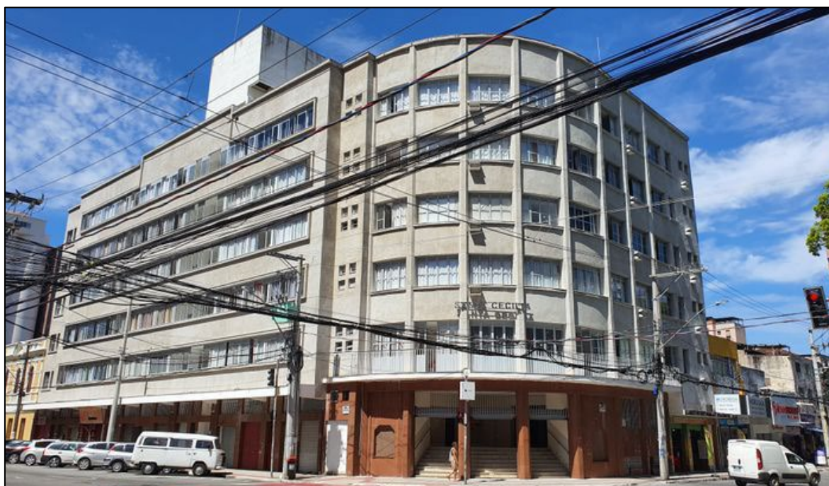
Figura 11 – Edifício Santa Cecília após reabilitação
