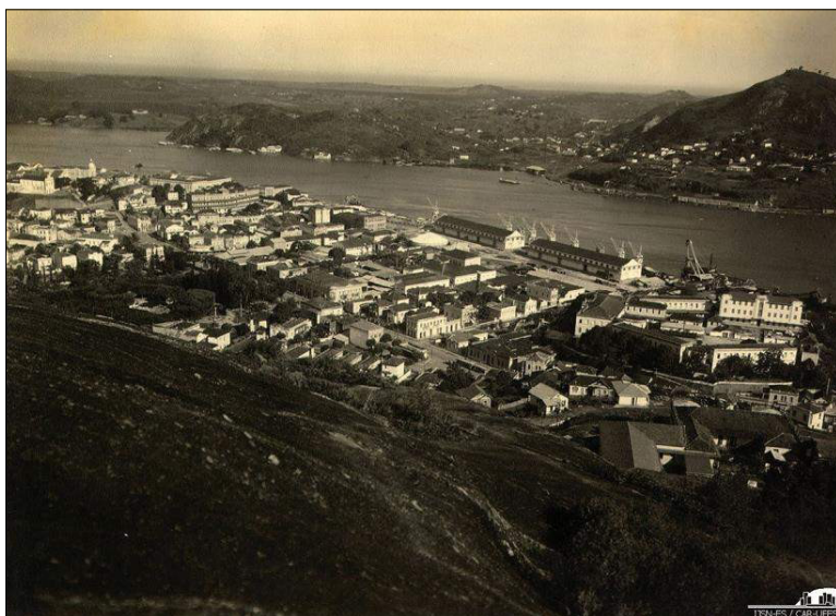
Figura 10 - Frente marítima com os Armazéns 1 e 2 do Porto de Vitória, a Baía e o município de Vila Velha ao fundo (1936).
