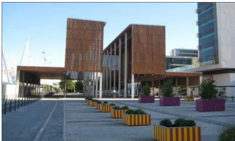
Figura 7 - Obra Porta Norte, de Manuel Táinha.
