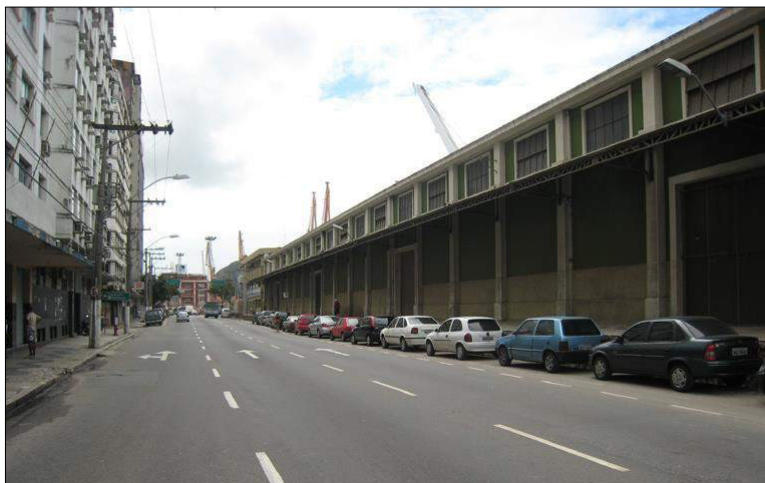
Figura 19 - Armazém 3 do Cais Comercial do Porto de Vitória (2009).
