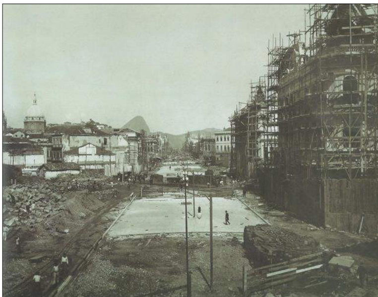
Figura 6 - Abertura da Avenida Central (1904).
