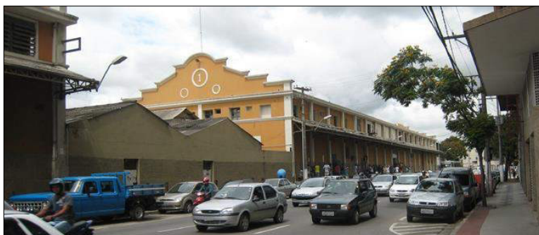
Figura 18 - Armazém 1 do Cais Comercial do Porto de Vitória (2009).
